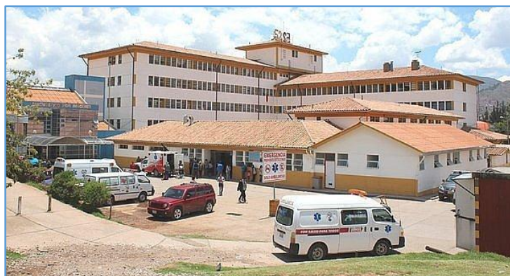
Figura 2: Las cubiertas de hospital regional de Cusco con teja cerámica.
