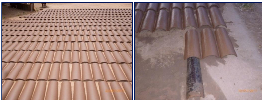
Figura 35: Secado al sol de tejas cerámicas mecanizada y artesanal. Fuente: Propia del autor.
