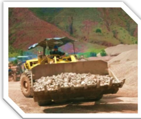
Fotografía 21. Traslado de material a la tolva de trituración.
