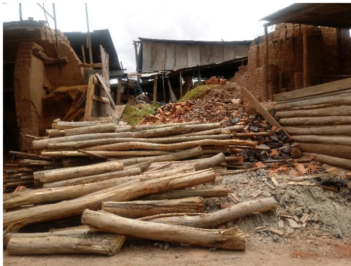
Figura 75: Peligro Locativo - Acceso al área de producción interrumpido por troncos. Fotografía Propia
