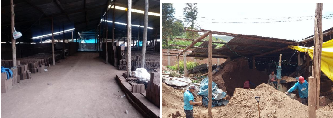
Figura 61: Riesgo Químico - Partículas, Polvo. Fotografía Propia
