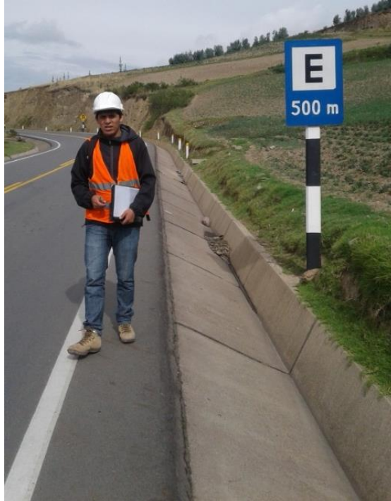
Figura 18. Exploración del tramo I. Fuente: Elaboración propia, 2018.
