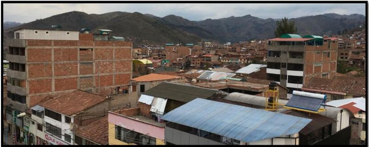
Figura 1: En el Cusco la mayor cantidad de edificaciones son construidas con ladrillos de arcilla.
