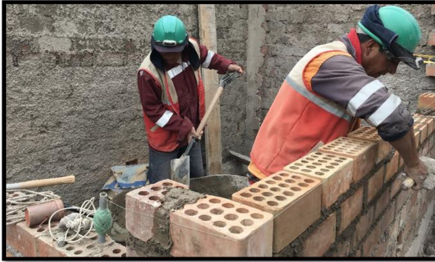
Figura 4: Proceso constructivo de muros para tabiquería - Cusco
