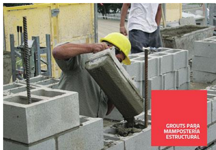
Figura 1: Grout utilizado en muros de albañilería armada.
