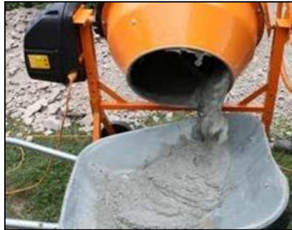
Figura 3: Mezcla de concreto.
