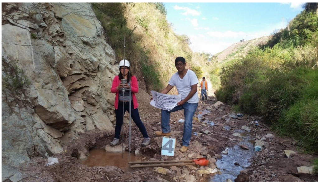
Figura 65: Ubicación del equipo del ensayo cono Sowers.
