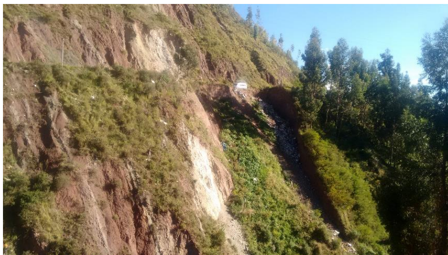
Figura 29 : Colocado de BM para el colocado de otro punto de referencia
