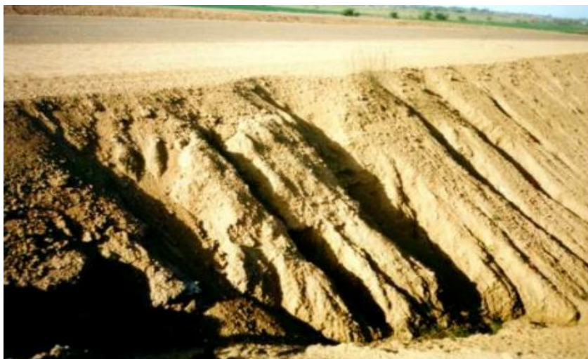
Figura 3 : Vista del talud que forma parte de un terraplén
