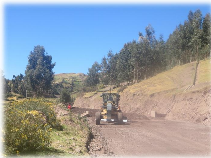
Fotografía 15: conformación de base
