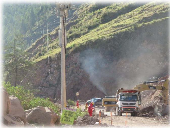
Fotografía 13: conformación de sub base
