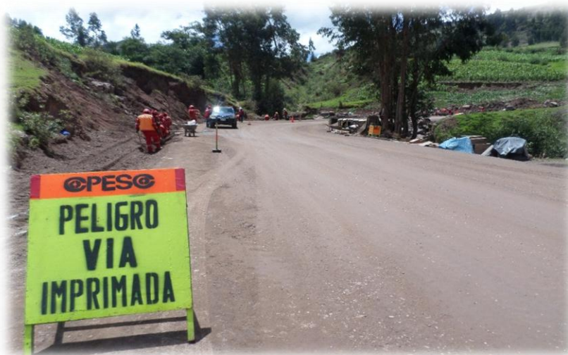
Fotografía 12: señalización en obra
