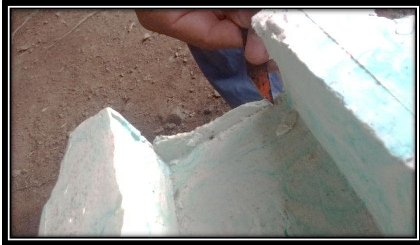
FIGURA N° 76 MEJORAMIENTO DEL CANAL DE SALIDA EN SILICONA
