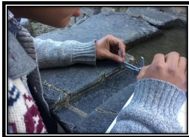
FIGURA N° 19 MEDICIÓN DEL ANCHO DEL CANAL DE SALIDA DE LA FUENTE DE LA ÑUSTA
