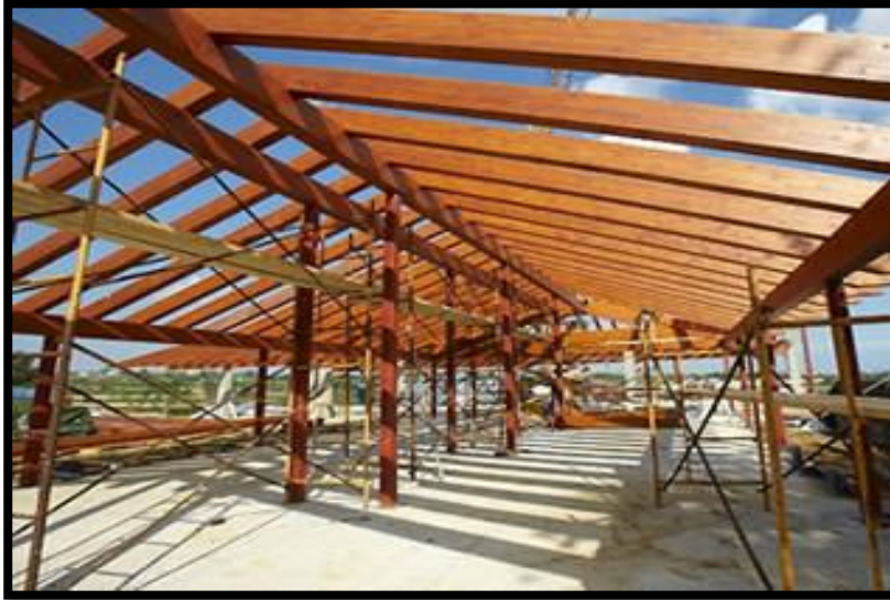
Figura N° 7 Estructura de madera 2.
