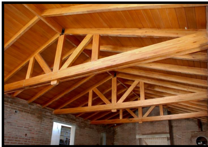
Figura N° 8 Techo con estructura de madera
