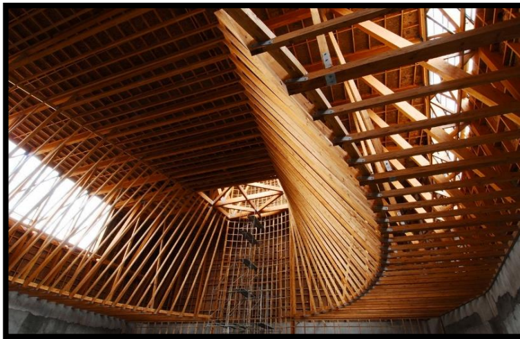
Figura N° 6 Estructura de madera 1.
