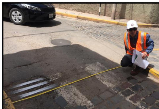
Figura 177. Sellado de sumidero en la Calle Recoleta.
