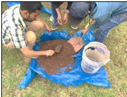
Figura 20: Mezcla de agua con tierra de la zona de Huancaro para la elaboración de unidades de albañilería
