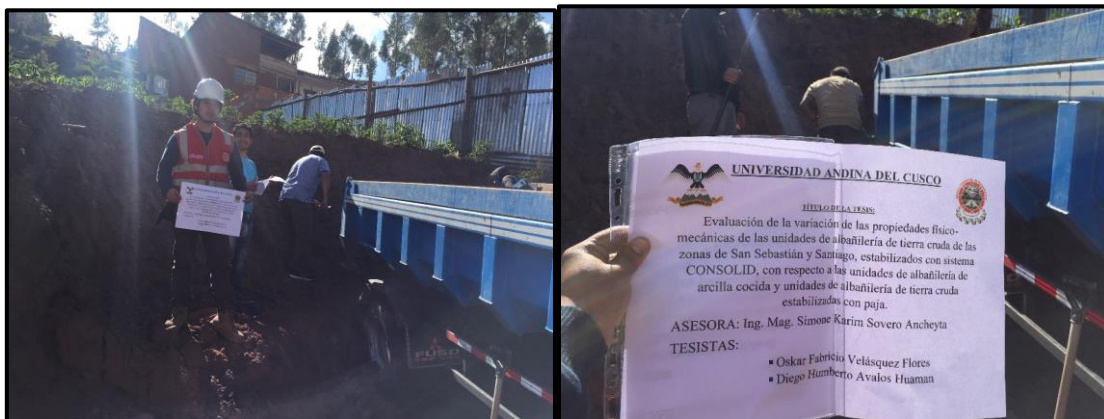
Figura 10: Extracción de material suelo de las zonas de San Sebastián y Santiago
