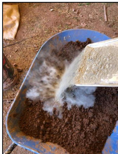
Figura 28: Mezclado de tierra con aditivo SOLIDRY
