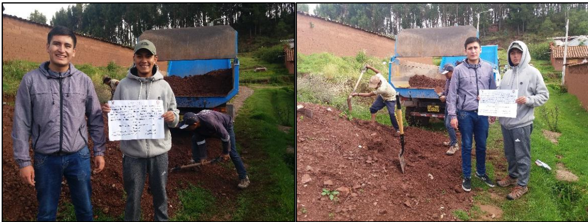
Figura N° 13: Extracción de Tierra de los Sectores Tambillo y PetroPerú.
