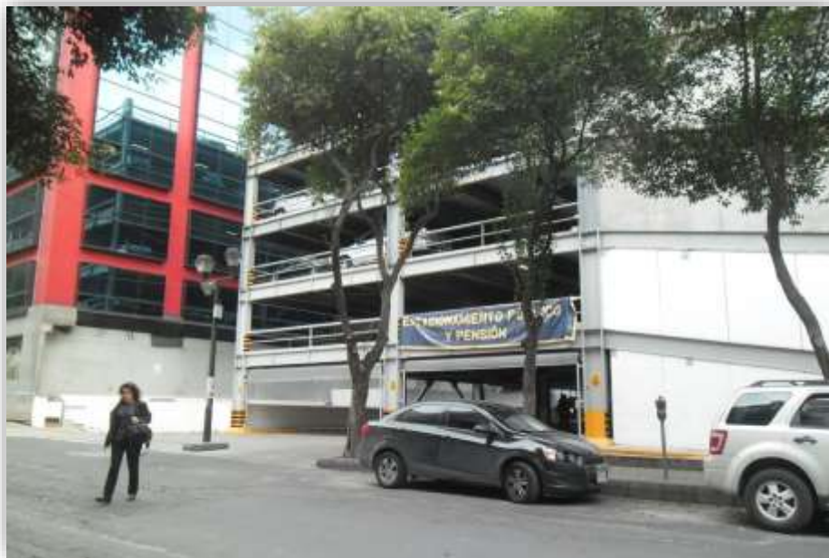
Figura N° 16: ESTACIONAMIENTO FUERA DE VÍA
