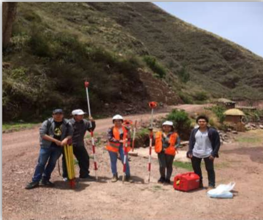
Figura N° 85: TESISTAS – ASISTENTES DE LEVANTAMIENTO TOPOGRÁFICO TRAMO III
