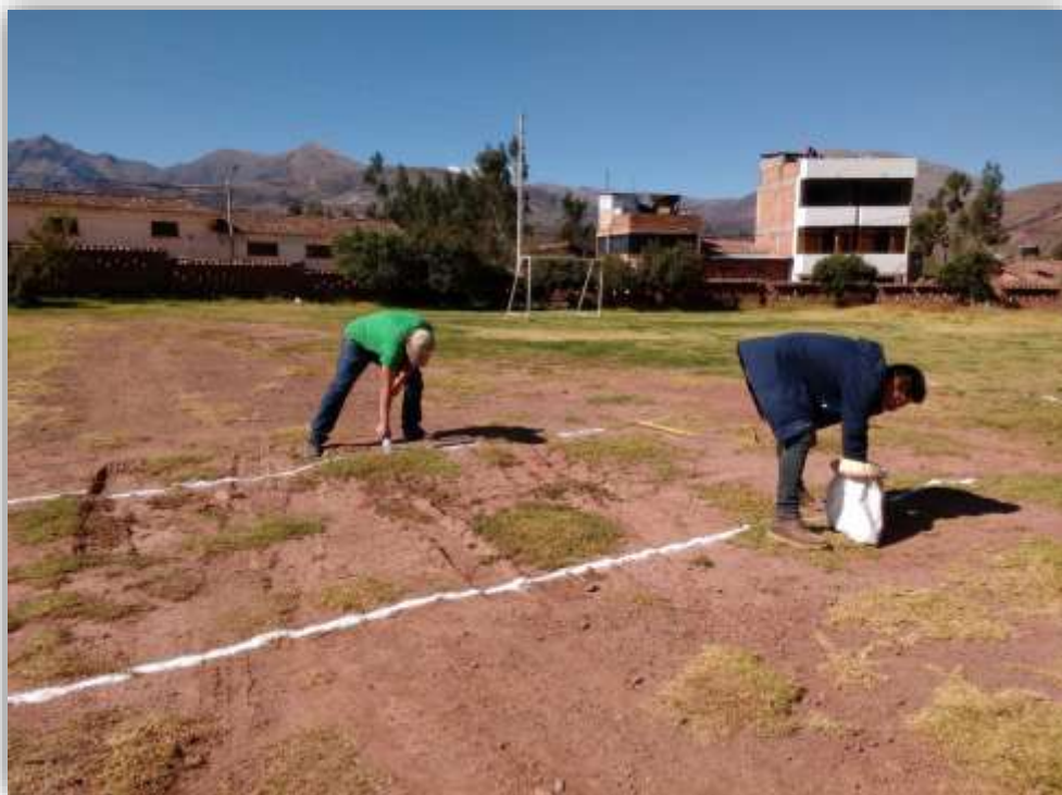
Figura N° 66: TRAZADO CON YESO DE LOS CAJONES DE ESTACIONAMIENTO
