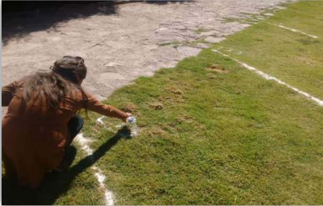
Figura N° 67: PINTADO DE NUMERACIÓN DE CAJONES DE ESTACIONAMIENTO
