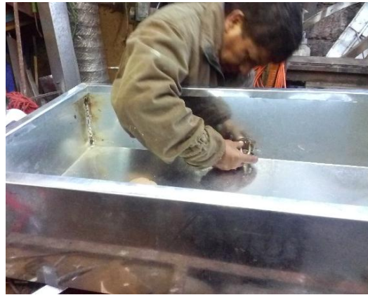
Fotografía 2: Colocado de resistencia eléctrica (1er intento)
