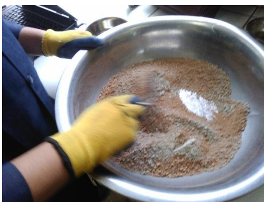
Fotografía 23: Mezclado del material fino con el cemento
