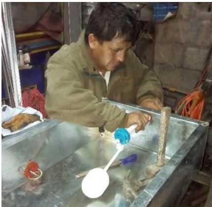
Fotografía 3: Instalación de bolla
