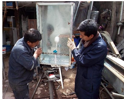
Fotografía 4: Instalación de sujetador de bolla y resistencia eléctrica (2do intento)
