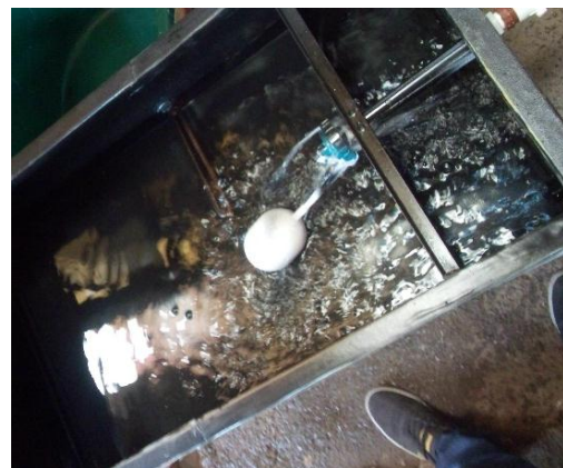
Fotografía 6: Verificación de bolla
