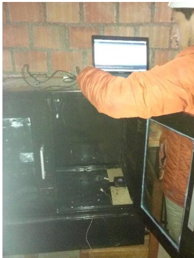
Fotografía 11: Instalación de los sensores
