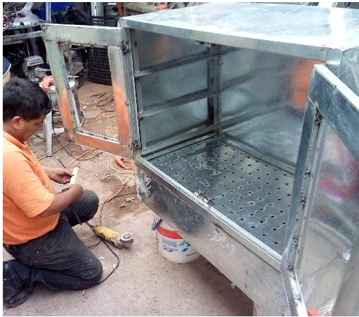
Fotografía 9: Armado de Cámara Húmeda
