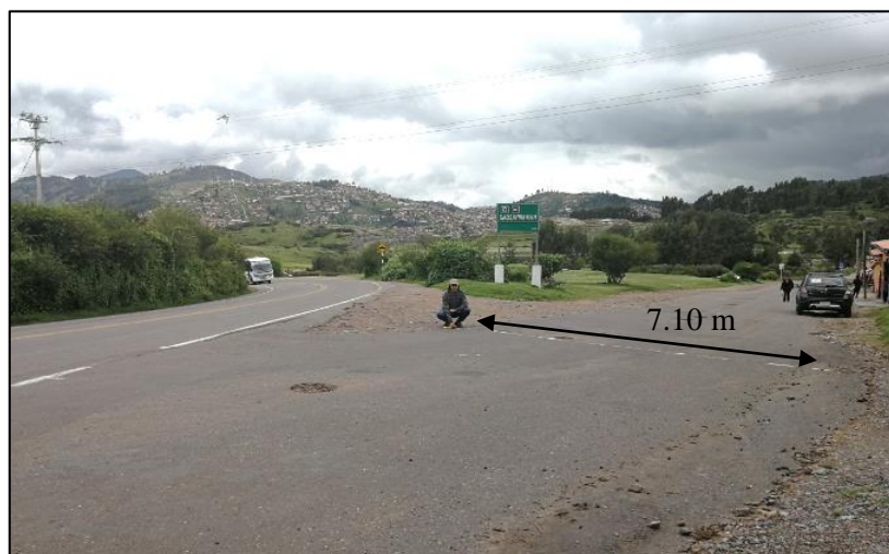
Figura 33. Medición del ancho de calzada de la Vía.
