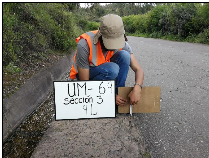
Figura 18. Desnivel Carril – Berma de severidad baja.
