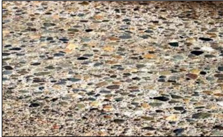
Figura 22. Pulimiento de Agregados.
