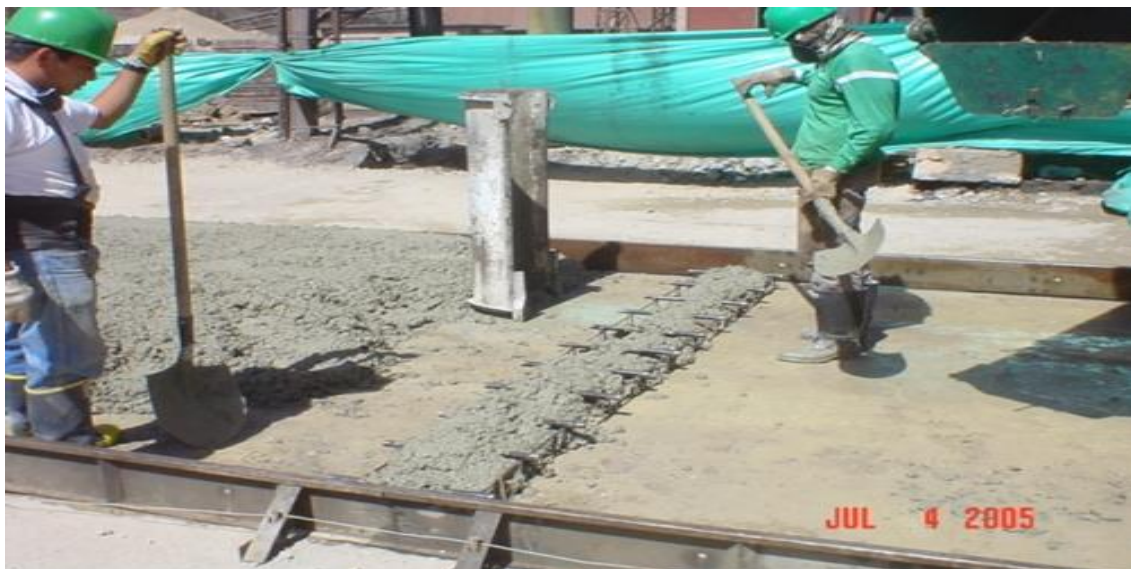
FIGURA N°13: Construcción vía de Pavimento Rígido
