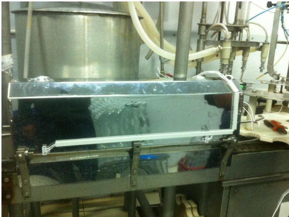
Figura 31. Aislamiento de cables por exterior.
