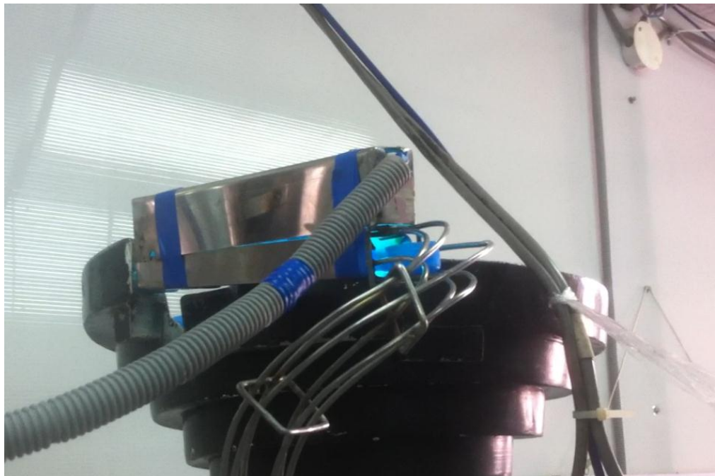
Figura 42. Cámara de desinfección de Tapas.
