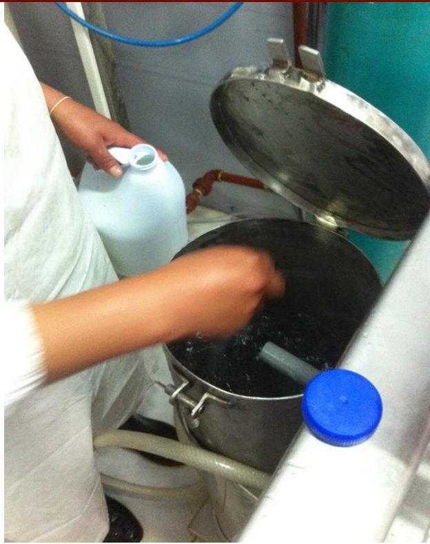
Figura 17. Dosificación del Hipoclorito de Sodio.
