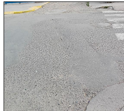
PARCHADO DE INSTALACIONES
