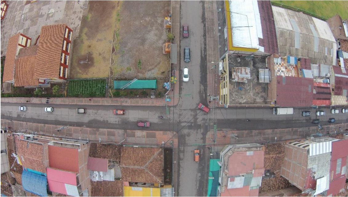
Figura 49: Av. Jorge Chávez con Jr. De la Unión - progresiva 0+760
