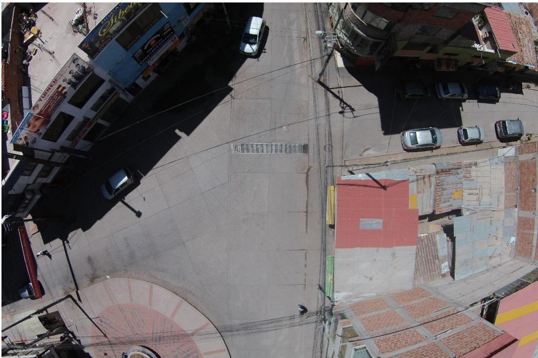
Figura 52: Av. Costanera con Jr. De la Unión - progresiva 0+581
