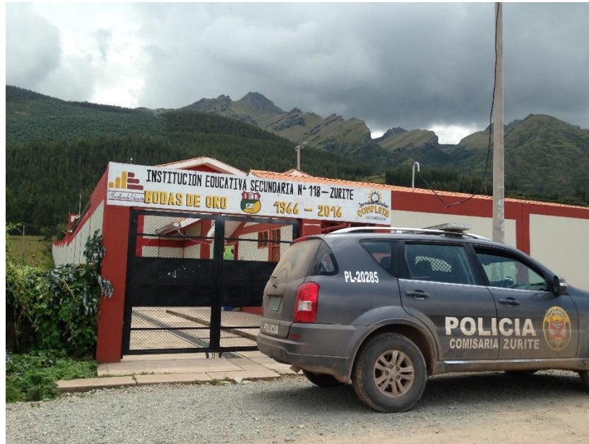
Figura 17: Fachada del Nuevo colegio 118 Nivel secundario de Zurite
