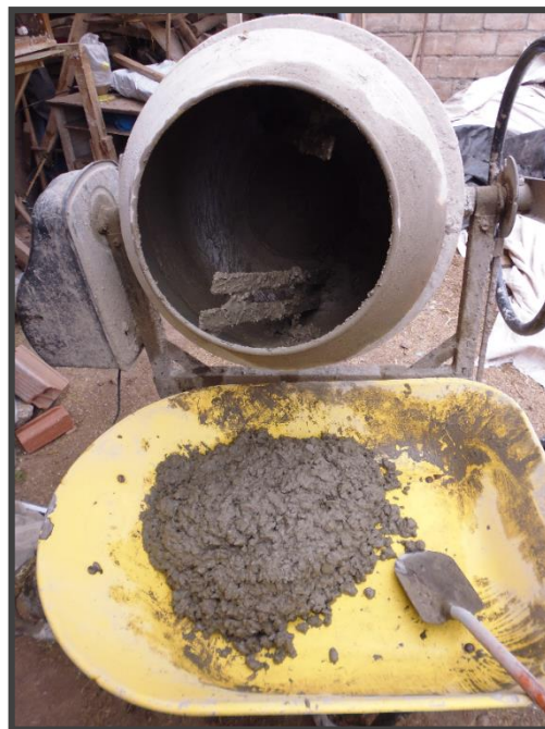
FIGURA 02: Concreto en Estado Plástico
