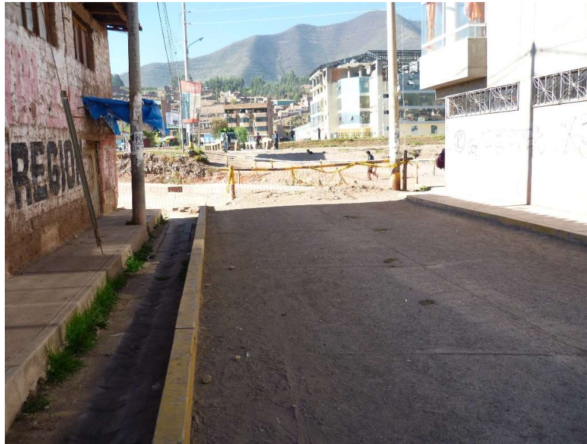
Figura N° 62 Bloqueo por modificaciones en la calzada del Eje N° 13 a la altura del Rio Huatanay vista en dirección sur
