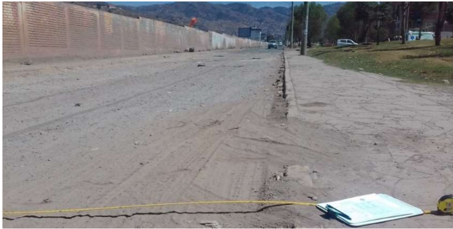
Figura N° 23 Wincha en mediciones geométricas de la Vía Expresa
