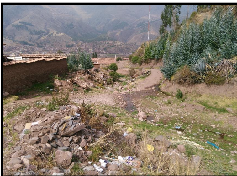
Fotografía N° 9, de la progresiva 00+00 en la que se muestra el punto de interés o por donde desaguara los máximos caudales.
