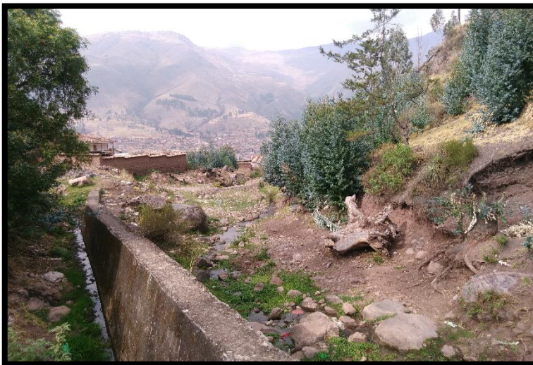
Fotografía N° 8, de la progresiva 00+00 en la que se muestra el inicio del área de estudio de peligrosidad.
