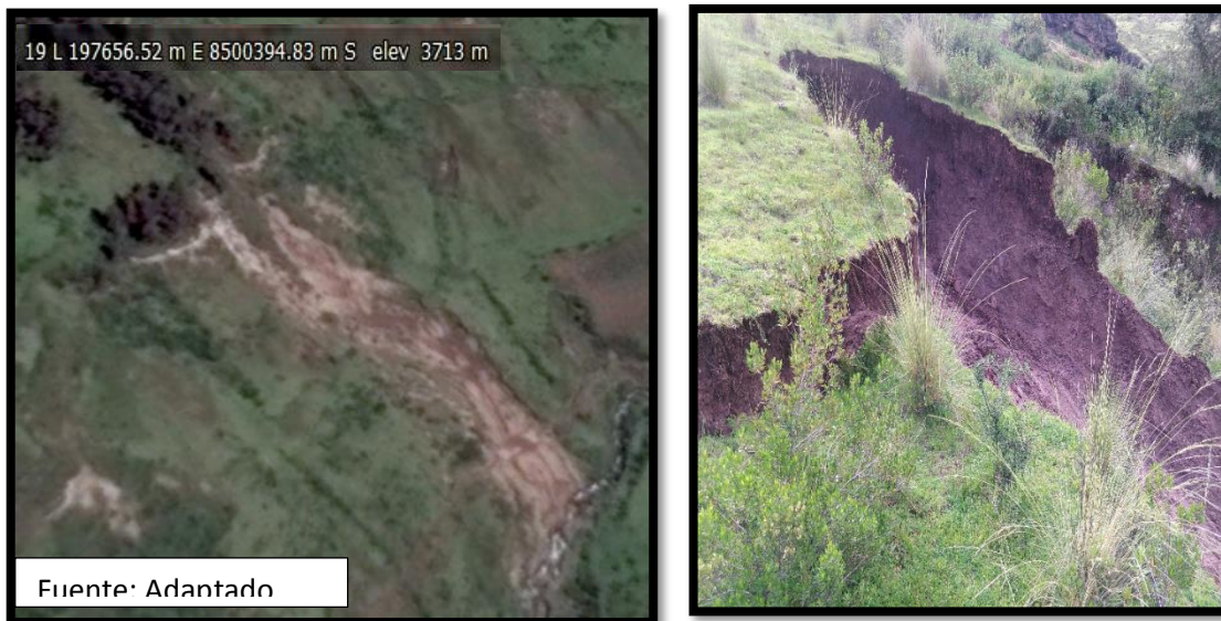
FIGURA N° 77: Imagen Satelital de la Zona de Estudio Talud N°-1
