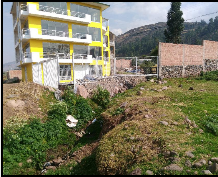
Fotografía N° 4, progresiva 00+590 en la que se muestra una vivienda nueva dentro del área vulnerable alta.
