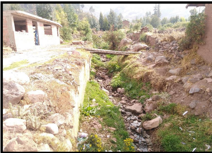
Fotografía N° 6, progresiva 00+480 en la que se muestra el relieve del río y la construcción de una vivienda la cual se encuentra a 7 metros de la ribera del río.
