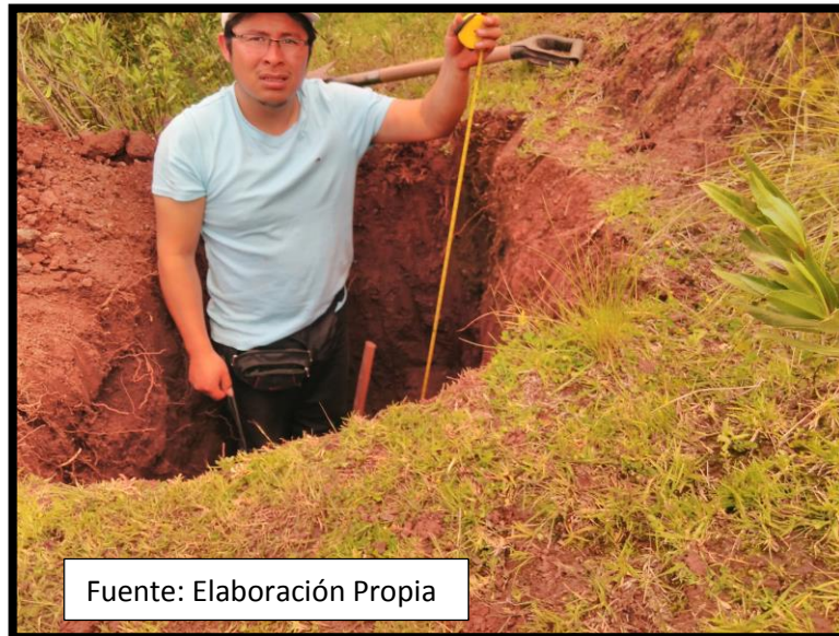
FIGURA N° 36: Realización de la Zanja de Inspección.
