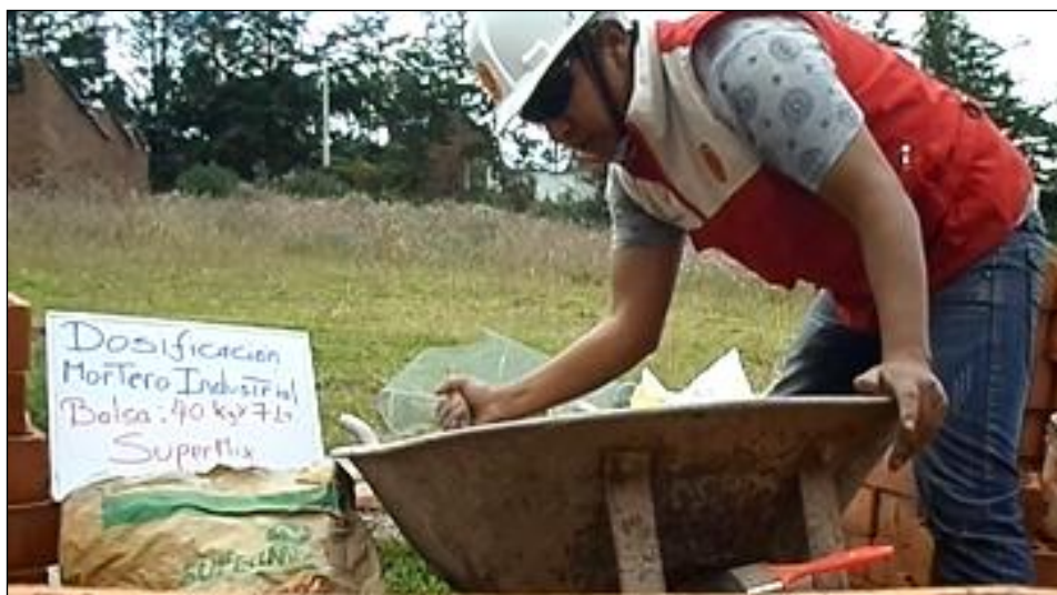
Figura. 108 Elaboración del Mortero y Dosificación del Mortero Industrial.
