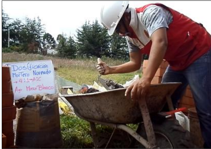
Figura. 107 Elaboración del Mortero y Dosificación del Mortero Normado.
