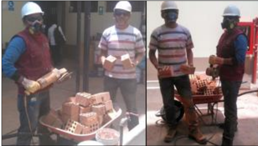
Figura. 99 Corte del Ladrillo en medias unidades.
