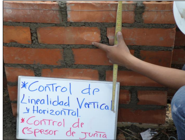
Figura. 126 Verificación del espesor de junta del murete. .
