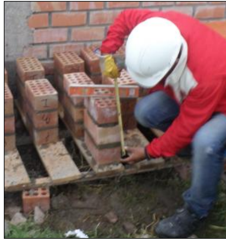
Figura. 111 Verificación de la horizontalidad, verticalidad y tamaño del espesor de junta.
