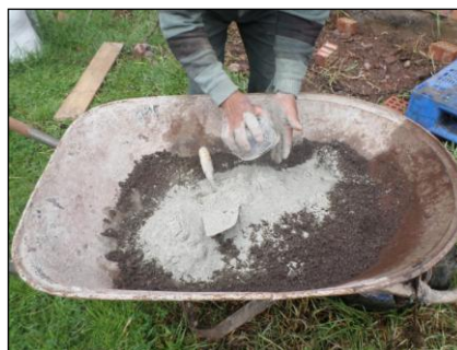
Figura. 105 Elaboración del Mortero.
