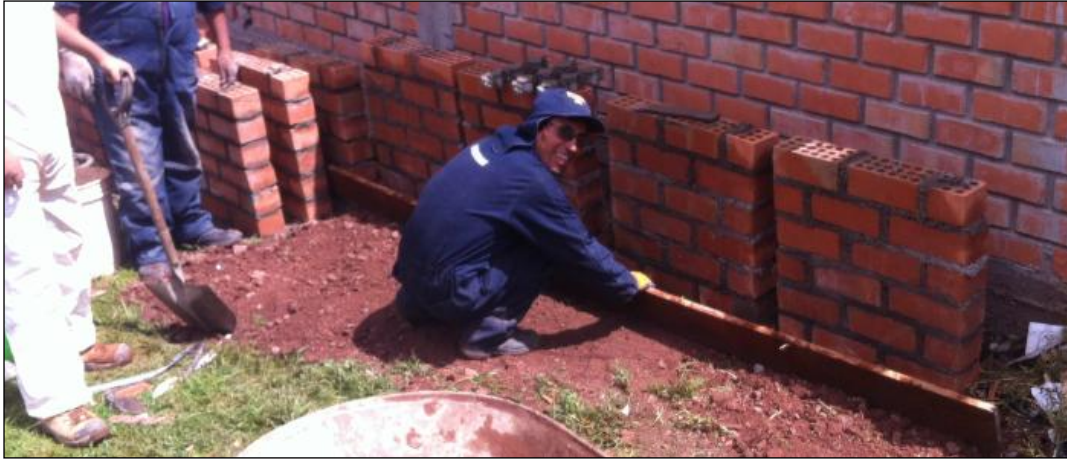
Figura. 120 Nivelación del terreno para asentar la primera hilada de ladrillos.
