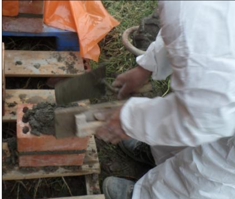
Figura. 109 Asentado del ladrillo Para elaborar una pila.
