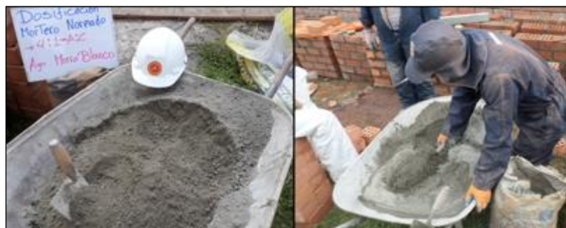
Figura. 80 Preparación y dosificación del Mortero Artesanal, Normado E industrial.
