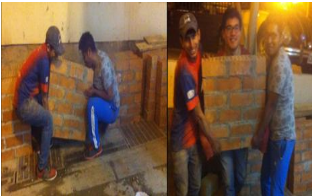
Figura. 132 Traslado de los muretes al laboratorio.
