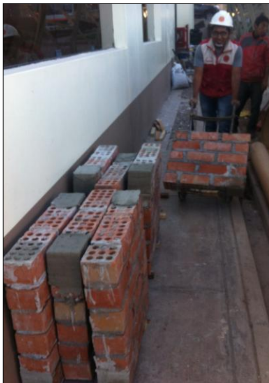
Figura. 131 Traslado de los muretes ya refrentados, listos para ser ensayados.
