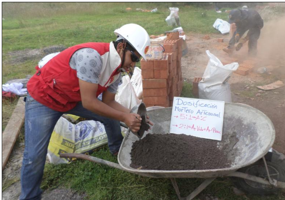
Figura. 106 Elaboración del Mortero y Dosificación del Mortero.
