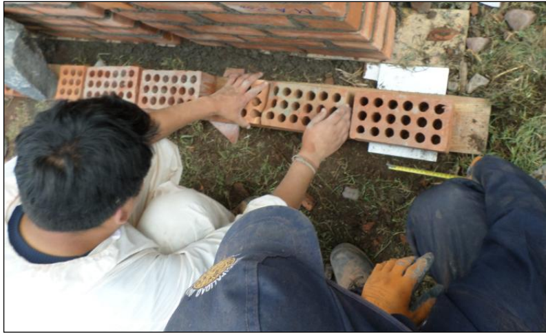
Figura. 122 Emplantillado de la primera hilada. .
