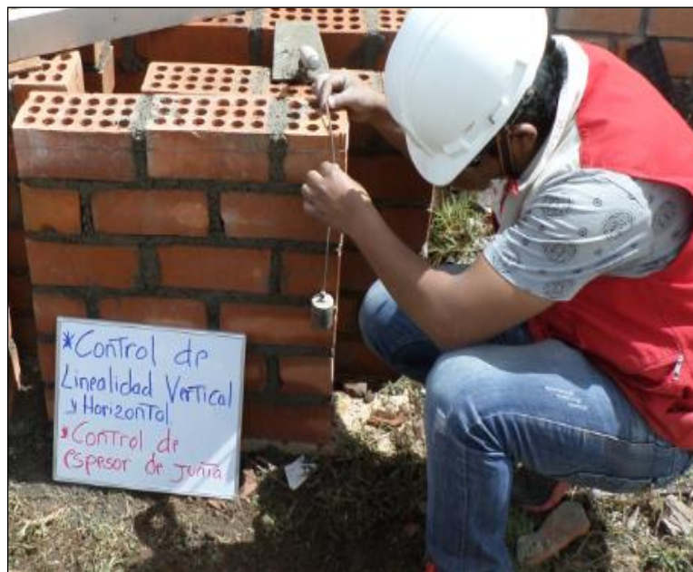
Figura. 125 Uso de Plomada para verificar la verticalidad del murete.
