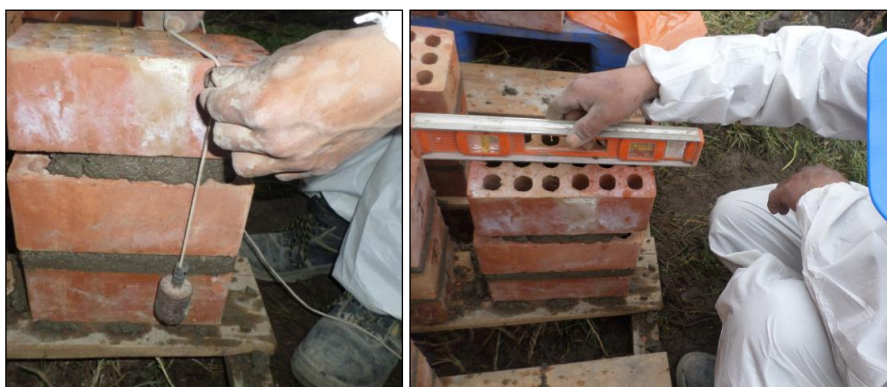
Figura. 110 Control de verticalidad – uso de plomada. Uso de nivel para asegurar la horizontalidad de la pila.
