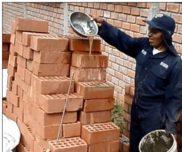
Figura. 119 Riego de los ladrillos antes de ser asentados.
