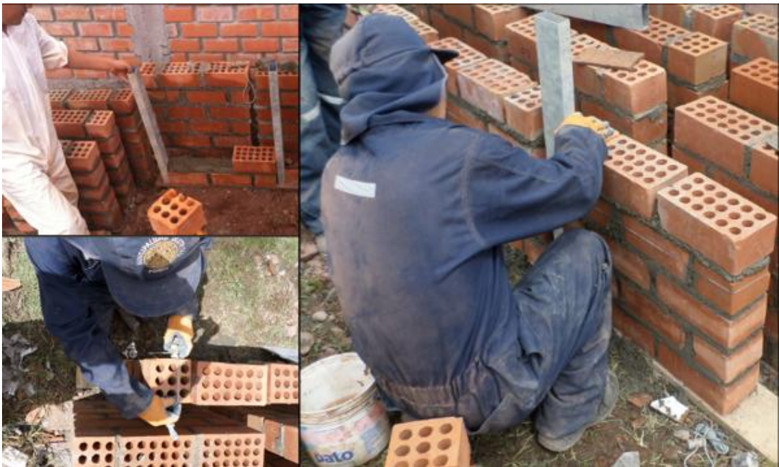
Figura. 123 uso de plomada y reglas para garantizar la verticalidad y horizontalidad del murete.
