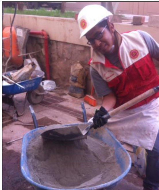
Figura. 129 mezclado y elaboración de la mezcla cemento y arena de 1:3 (C: A).
