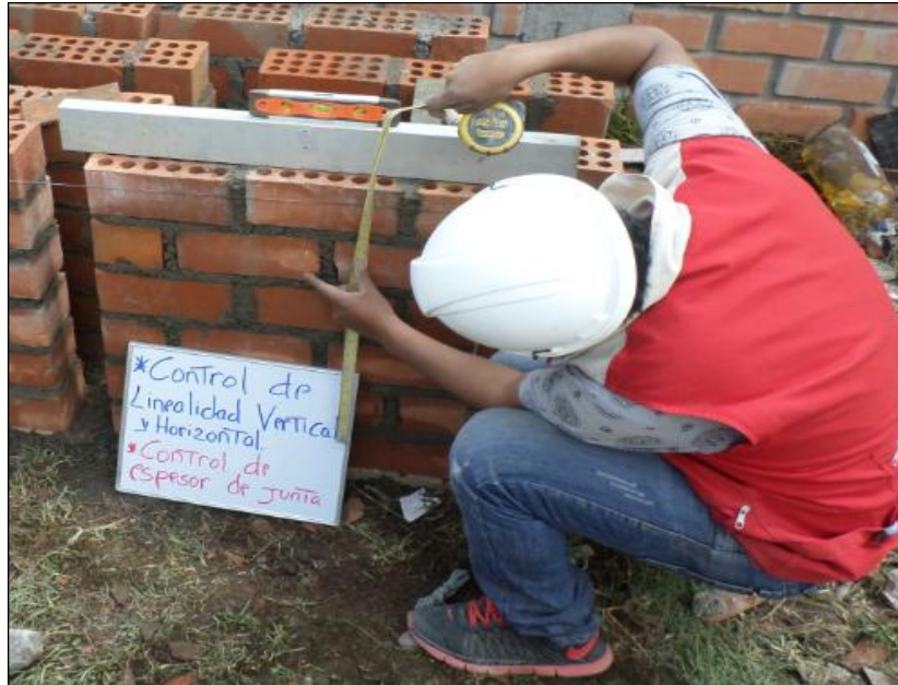
Figura. 124 Uso de regla y nivel para verificar la horizontalidad del murete
