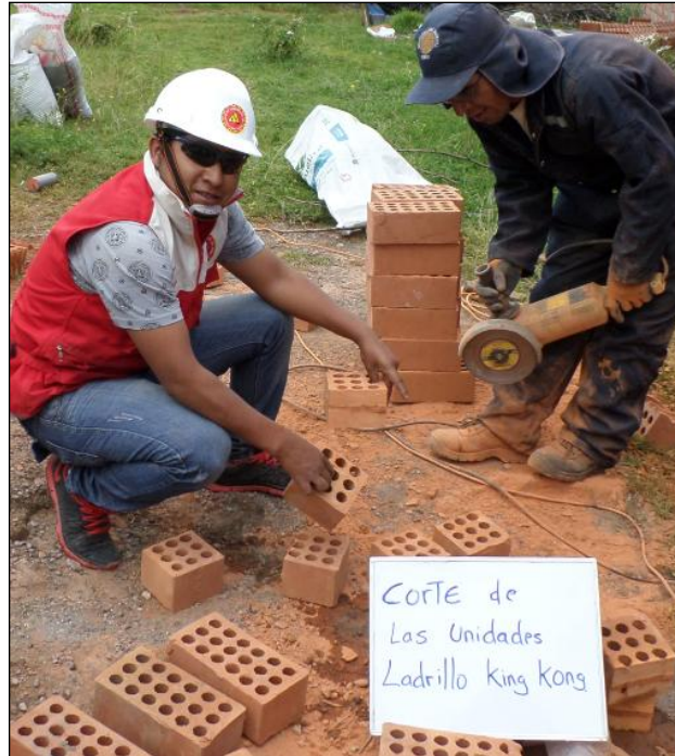
Figura. 118 Corte de del ladrillo para la elaboración de muretes.
