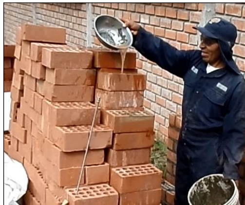
Figura. 104 Riego antes de utilizar el Ladrillo.
