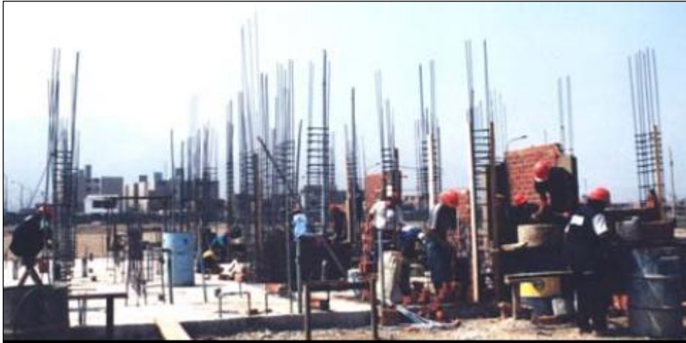
Figura. 8 . Elaboración de Muros portantes.
