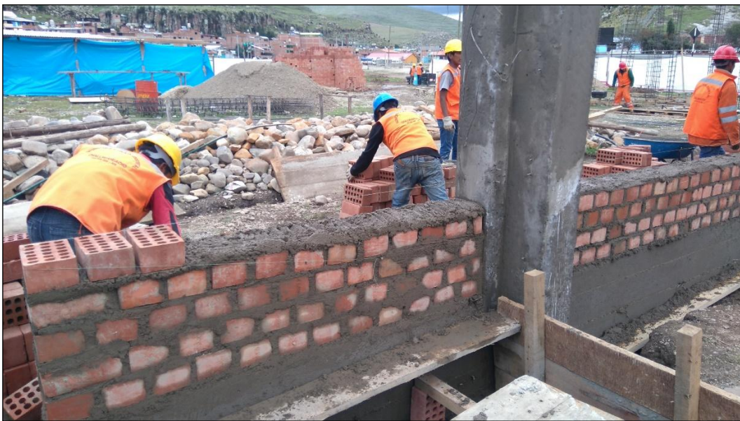
Figura. 3 Proceso constructivo de muros de albañilería – Santiago.
