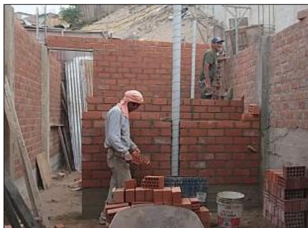
Figura. 7 . Muro no portante.
