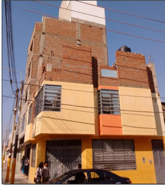
Figura. 9 Muros no reforzados o de albañilería simple.
