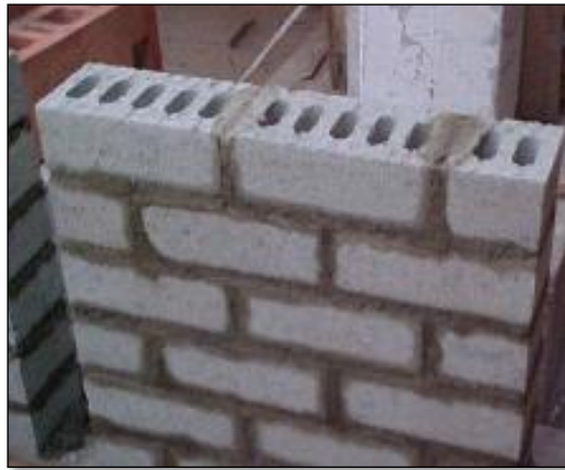
Figura. 20 Unidades de albañilería de concreto.
