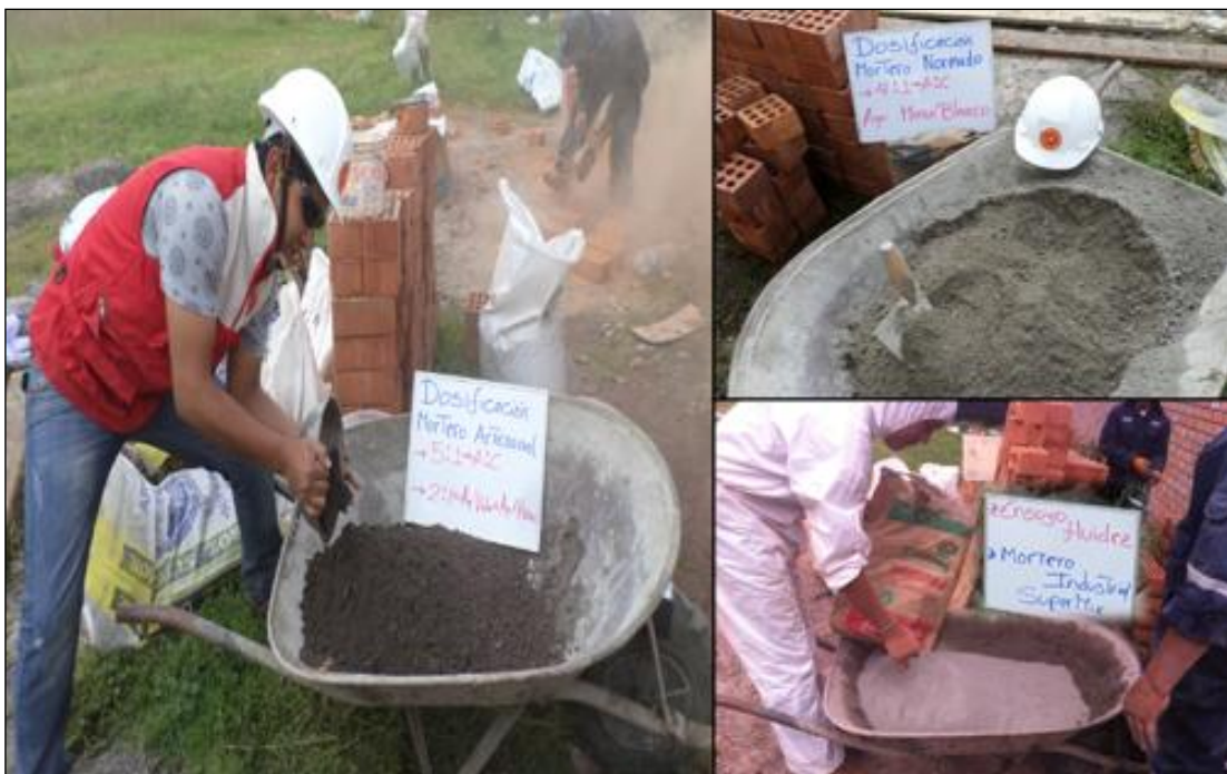
Figura. 79 Preparación y dosificación del Mortero Artesanal, Normado E industrial.
