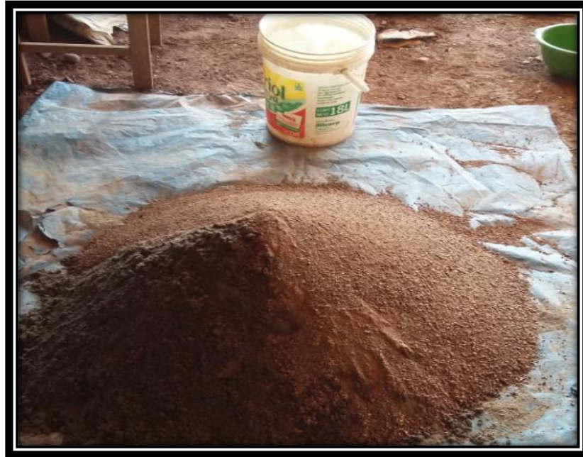
FIGURA N° 105 DOSIFICACIÓN PARA MORTERO CEMENTO ARENA 1:4
