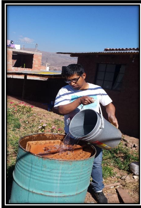
FIGURA N° 115 SATURACIÓN DE BLOCKER APROXIMADAMENTE 30 MINUTOS 10 HORAS ANTES DEL ASENTADO.
