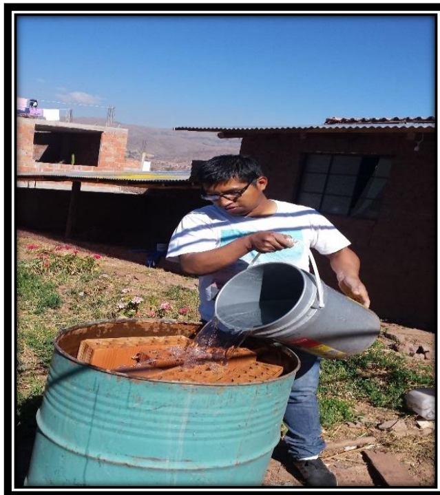
FIGURA N° 110 SATURACIÓN DE LADRILLOS BLOCKER APROXIMADAMENTE DURANTE 30 MINUTOS 10 HORAS ANTES DEL ASENTADO.
