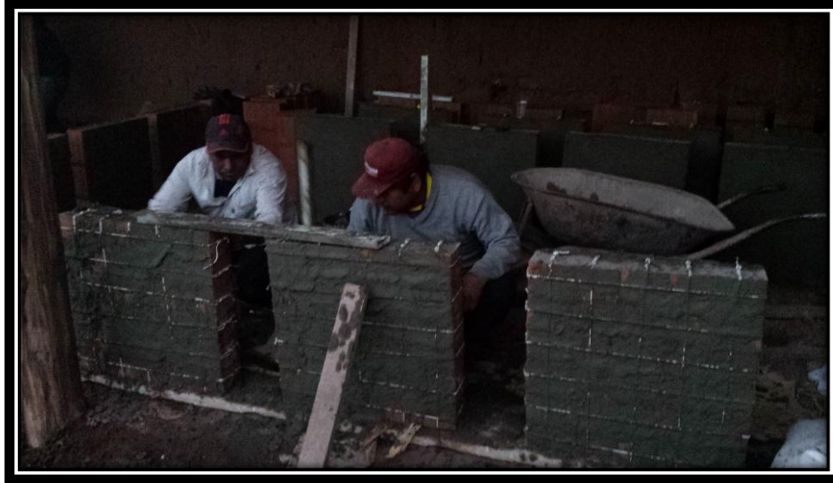
FIGURA N° 107 TARRAJEO DE MURETES DE ALBAÑILERÍA UTILIZANDO LADRILLO KING KONG 18 HUECOS REFORZADO CON SOGA DRIZA.
