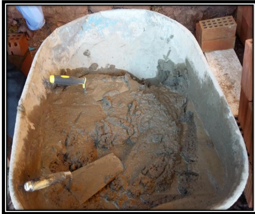
FIGURA N° 111 DOSIFICACIÓN PARA MORTERO DE CEMENTO ARENA 1:4
