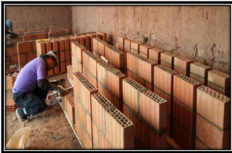
FIGURA N° 112 ASENTADO DE MURETES DE ALBAÑILERÍA UTILIZANDO BLOCKER.
