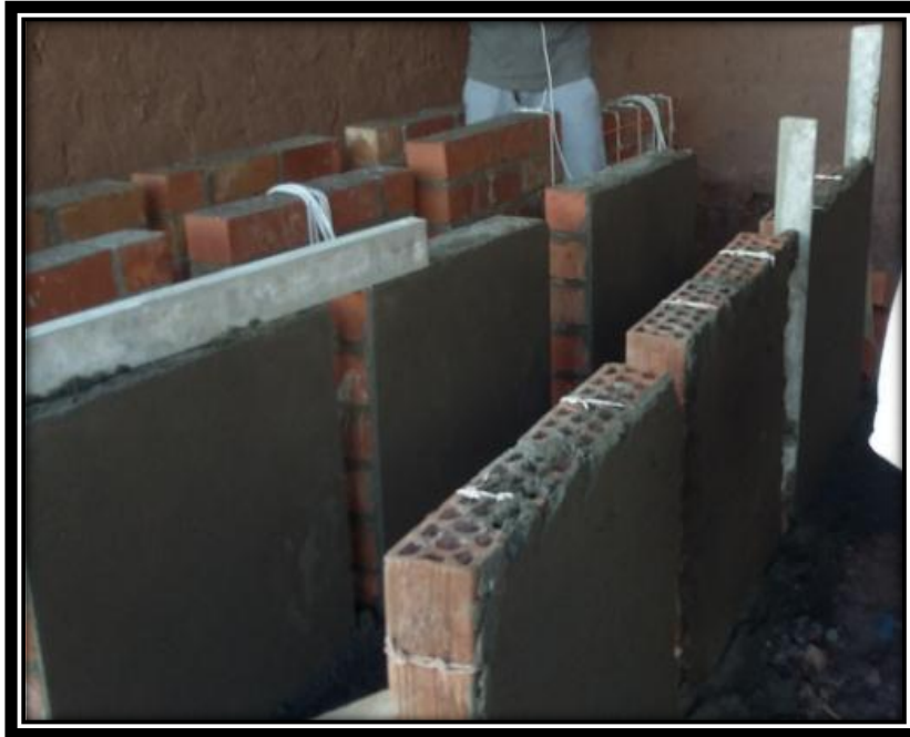
FIGURA N° 122 TARRAJEO DE LOS MURETES DE ALBAÑILERÍA UTILIZANDO BLOCKER REFORZADO CON SOGA DRIZA.
