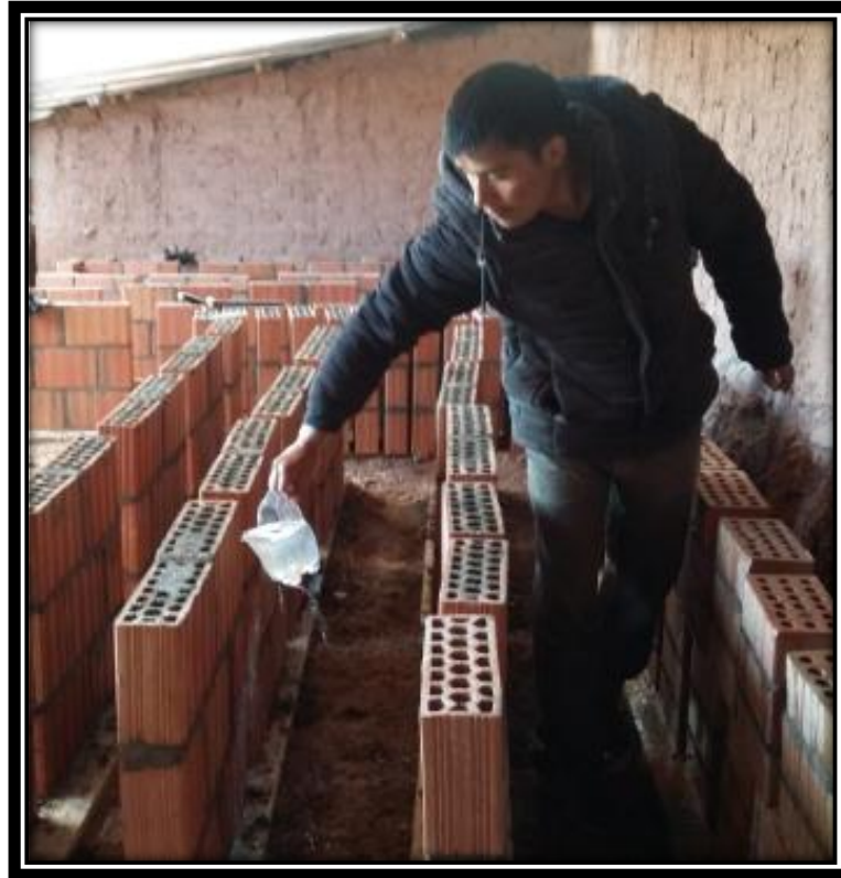
FIGURA N° 120 CURADO DE LOS MURETES DE ALBAÑILERÍA UTILIZANDO BLOCKER.
