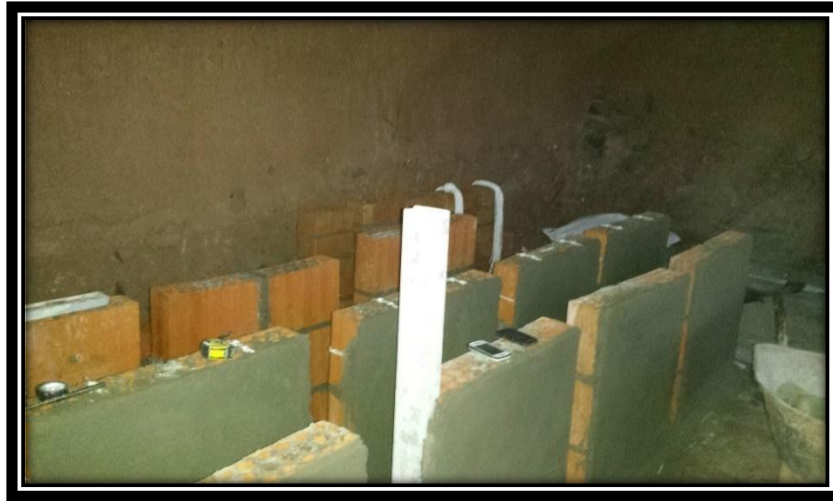
FIGURA N° 117 TARRAJEO DE MURETES DE ALBAÑILERÍA UTILIZANDO BLOCKER.
