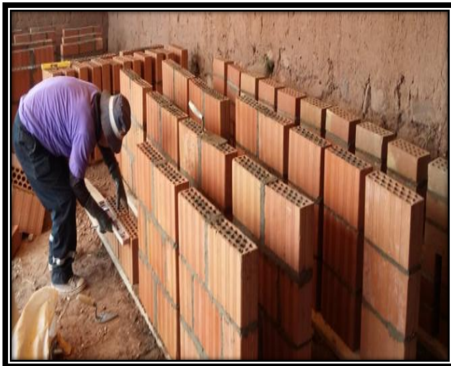
FIGURA N° 116 ASENTADO DE MURETES DE ALBAÑILERÍA UTILIZANDO BLOCKER.
