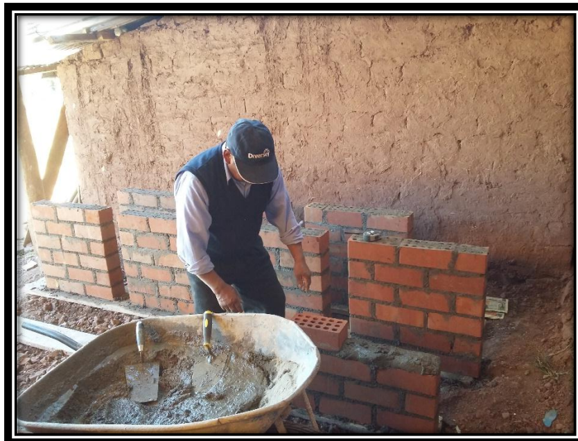
FIGURA N° 101 ASENTADO DE MURETES DE ALBAÑILERÍA UTILIZANDO LADRILLOS KING KONG 18 HUECOS
