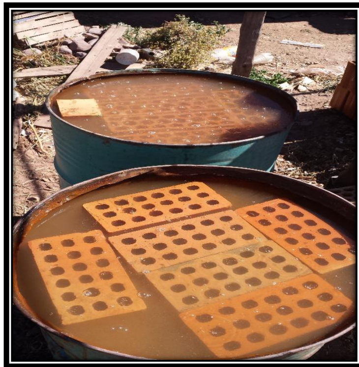
FIGURA N° 95 SATURACIÓN DE LOS LADRILLOS KING KONG 18 HUECOS APROXIMADAMENTE DURANTE 30 MINUTOS 10 HORAS ANTES DEL ASENTADO.
