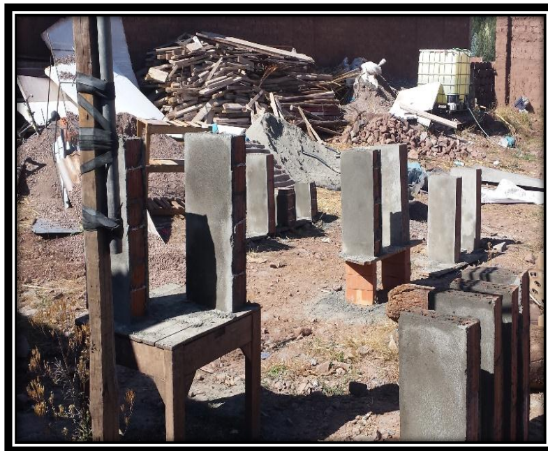
FIGURA N° 91 TARRAJEO EN PILAS DE ALBAÑILERÍA UTILIZANDO BLOCKER REFORZADO CON SOGA DRIZA.
