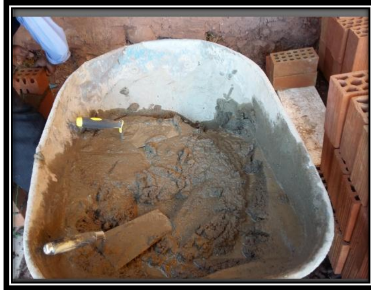
FIGURA N° 70 PREPARACIÓN DE MORTERO CEMENTO ARENA 1:4
