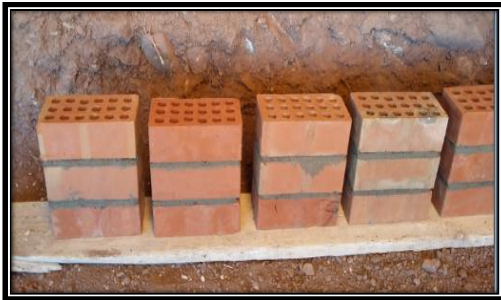
FIGURA N° 75 ASENTADO DE PILAS DE ALBAÑILERÍA UTILIZANDO LADRILLOS KING KONG DE 18 HUECOS.
