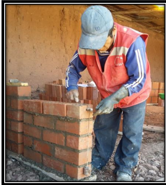
FIGURA N° 96 ASENTADO DE MURETES DE ALBAÑILERÍA UTILIZANDO LADRILLOS KING KONG 18 HUECOS.
