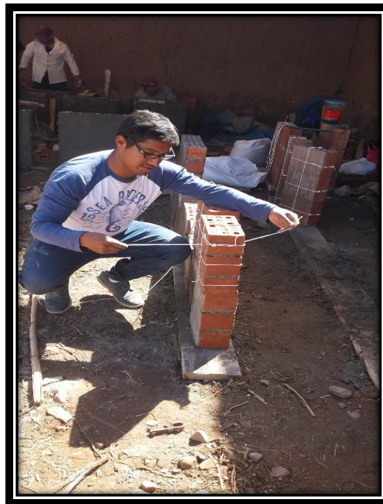
FIGURA N° 79 ASENTADO Y AMARRE EN PILAS DE ALBAÑILERÍA UTILIZANDO LADRILLOS KING KONG DE 18 HUECOS.
