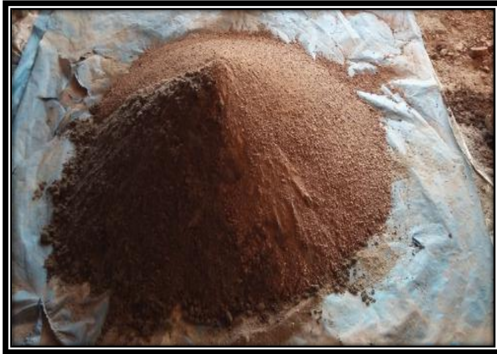
FIGURA N° 74 PREPARACIÓN DE MORTERO DOSIFICACIÓN CEMENTO ARENA 1:4.
