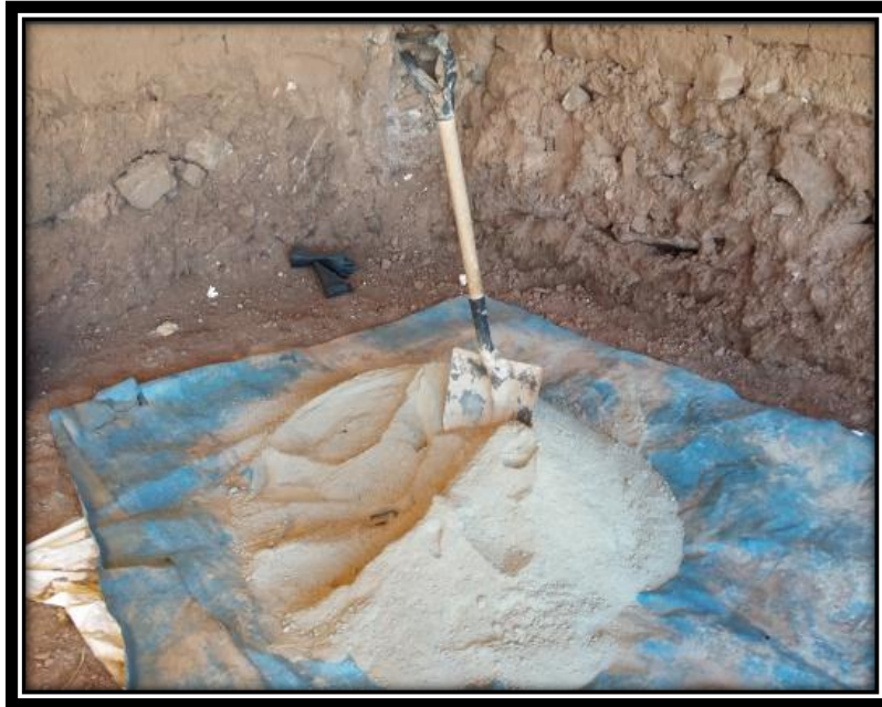
FIGURA N° 86 MEZCLADO DE MORTERO DOSIFICACIÓN CEMENTO ARENA 1:4.
