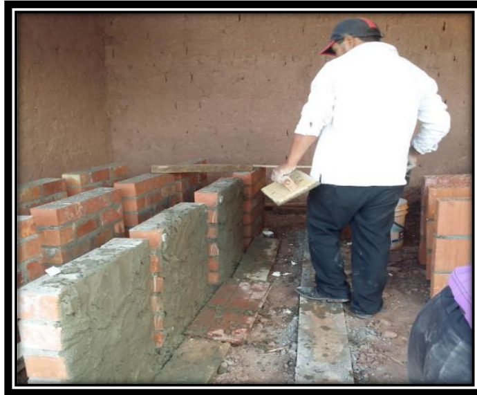
FIGURA N° 102 TARRAJEO DE MURETES DE ALBAÑILERÍA UTILIZANDO LADRILLOS KING KONG 18 HUECOS.
