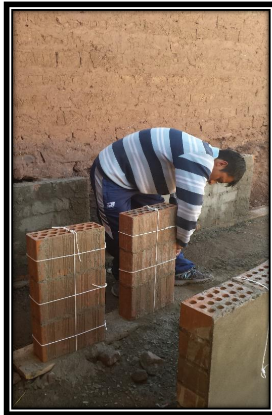
FIGURA N° 90 ASENTADO Y AMARRE EN PILAS DE ALBAÑILERÍA DE BLOCKER.
