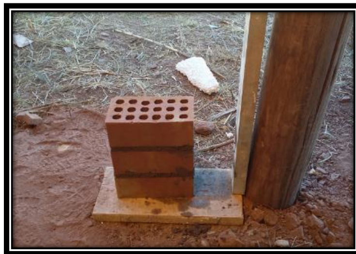
FIGURA N° 71 ASENTADO DE PILAS DE ALBAÑILERÍA UTILIZANDO LADRILLOS KING KONG DE 18 HUECOS
