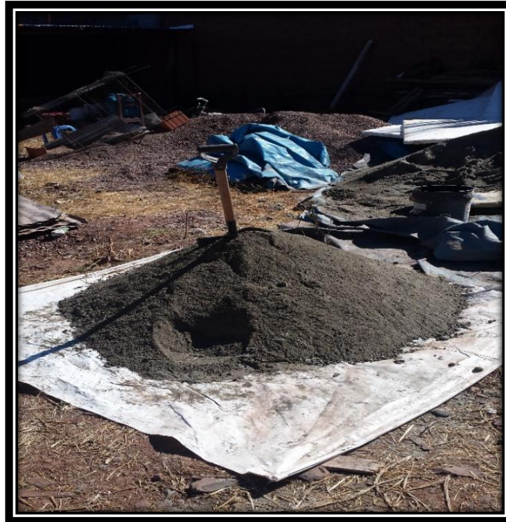
FIGURA N° 100 DOSIFICACIÓN PARA MORTERO CEMENTO ARENA 1: 4
