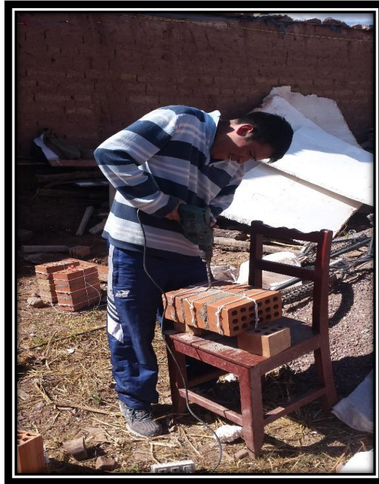
FIGURA N° 78 TALADRADO EN PILAS DE ALBAÑILERÍA USANDO LADRILLO KING KONG 18 HUECOS REFORZADOS CON SOGA DRIZA.
