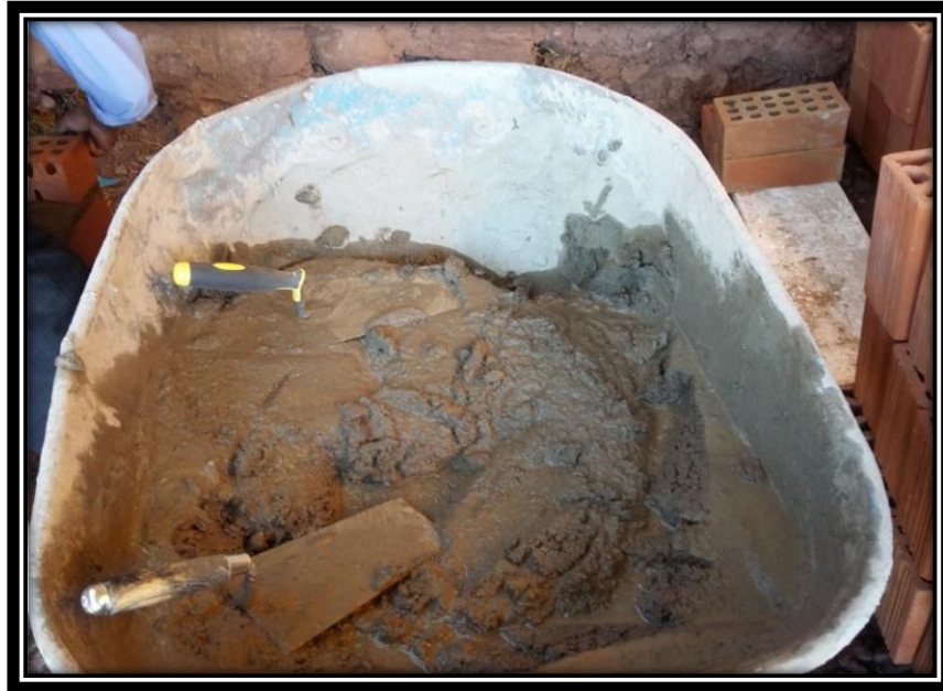
FIGURA N° 94 PREPARACIÓN DE MORTERO, DOSIFICACIÓN CEMENTO ARENA 1:4.
