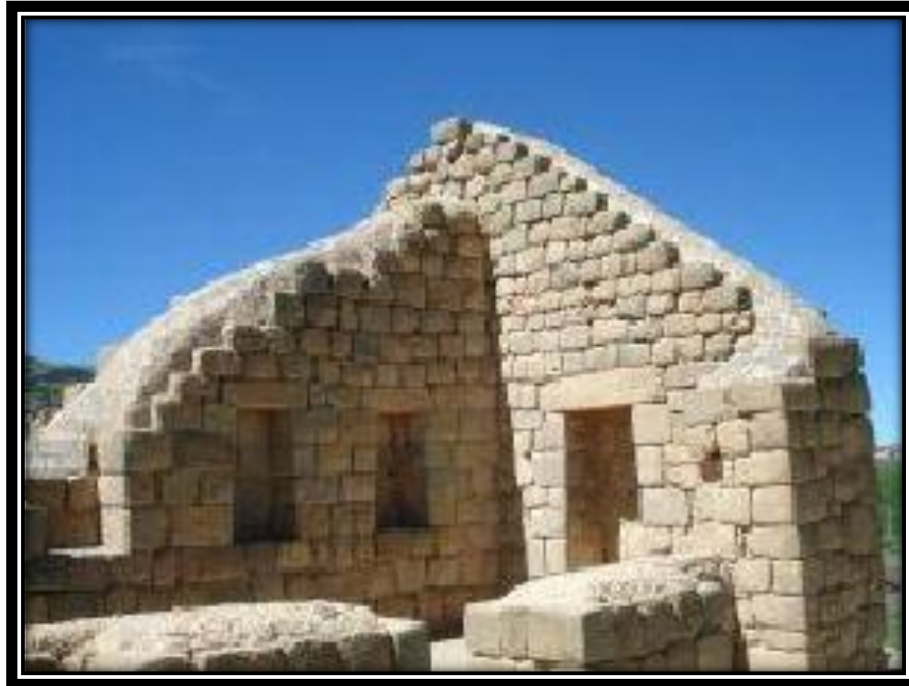
FIGURA N° 3 ALBAÑILERÍA DENOMINADA “PIRCA”
