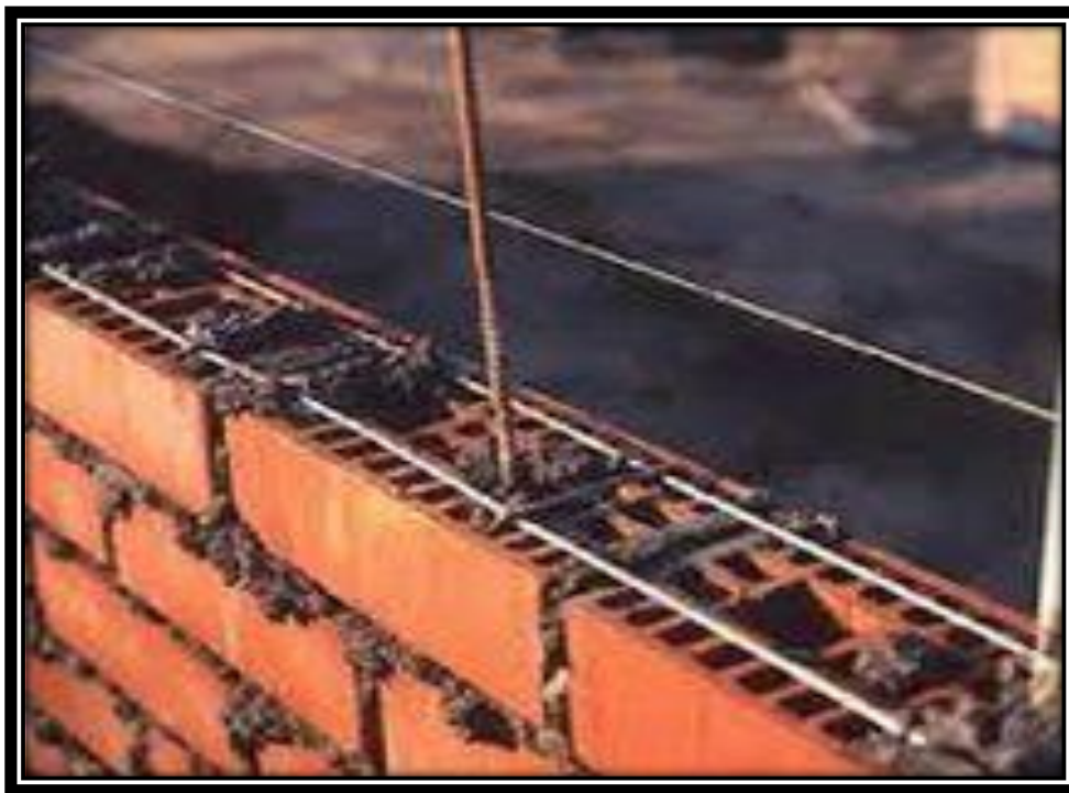
FIGURA N° 6 ALBAÑILERÍA ARMADA CON REFUERZO VERTICAL Y HORIZONTAL
