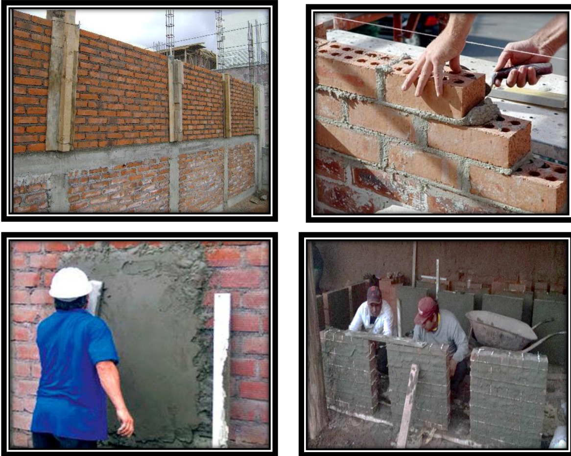
FIGURA N° 1 UNIDADES DE ALBAÑILERÍA ASENTADOS, TARRAJEADAS Y REFORZADAS
