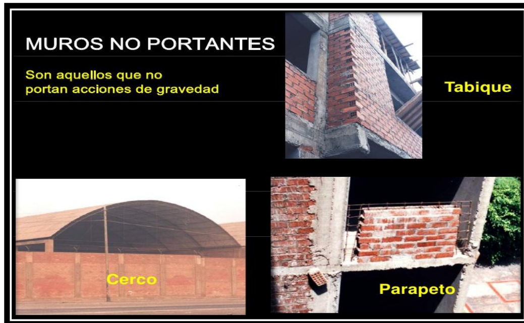
FIGURA N° 4 MUROS NO PORTANTES
