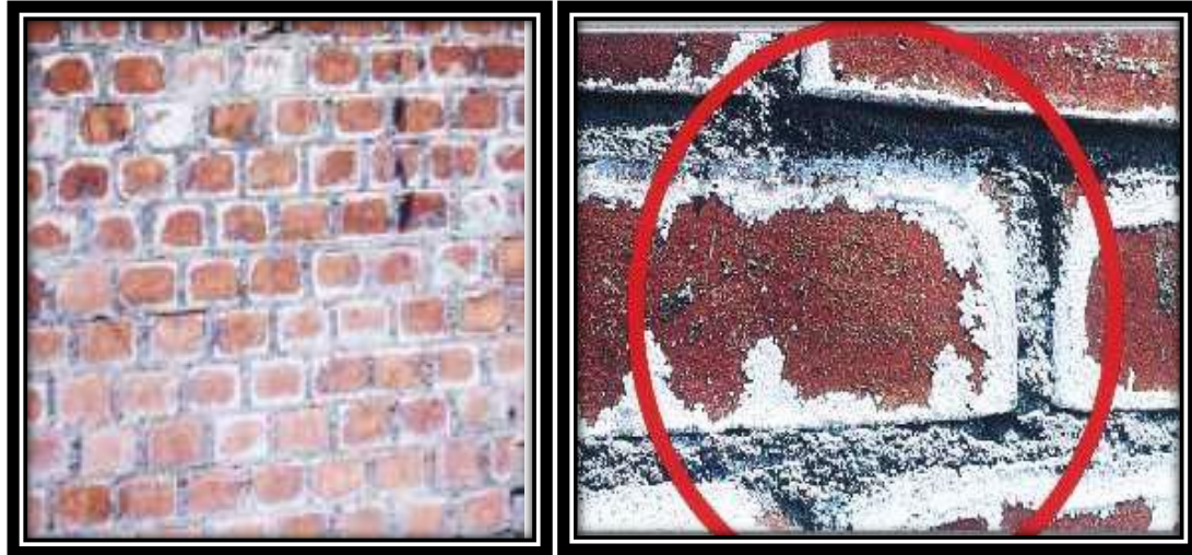
FIGURA N° 24 DESCRIPCIÓN: EFLORESCENCIA
