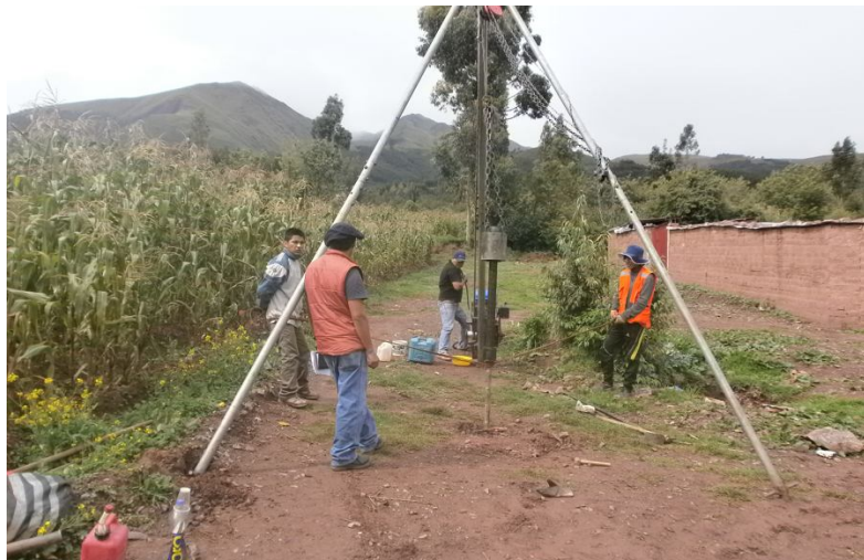
Figura 103. Realizacion de la prueba de SPT
