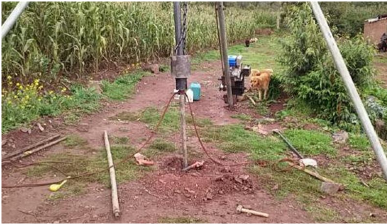
Figura 52. Instalacion del equipo de SPT
