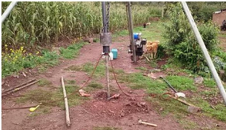
Figura 92. Instalacion del equipo de SPT
