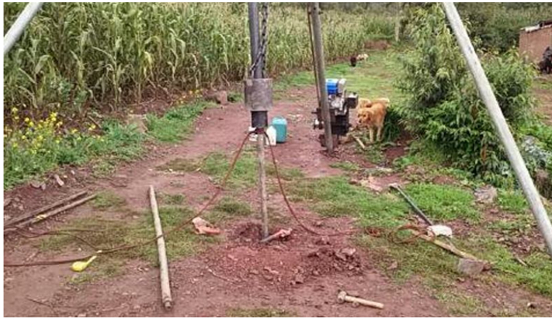
Figura 77. Instalacion del equipo de SPT
