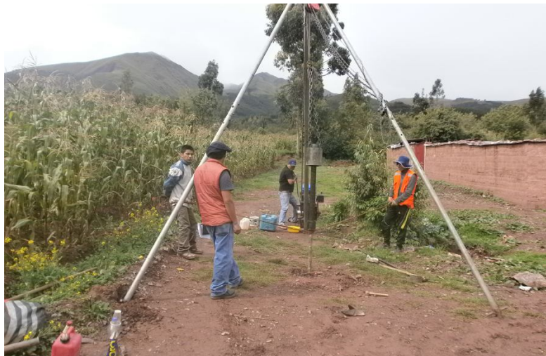
Figura 47. Realizacion de la prueba de SPT
