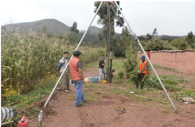
Figura 53. Realizacion de la prueba de SPT
