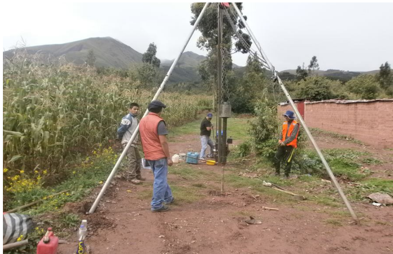
Figura 17. Realizacion de la prueba de SPT
