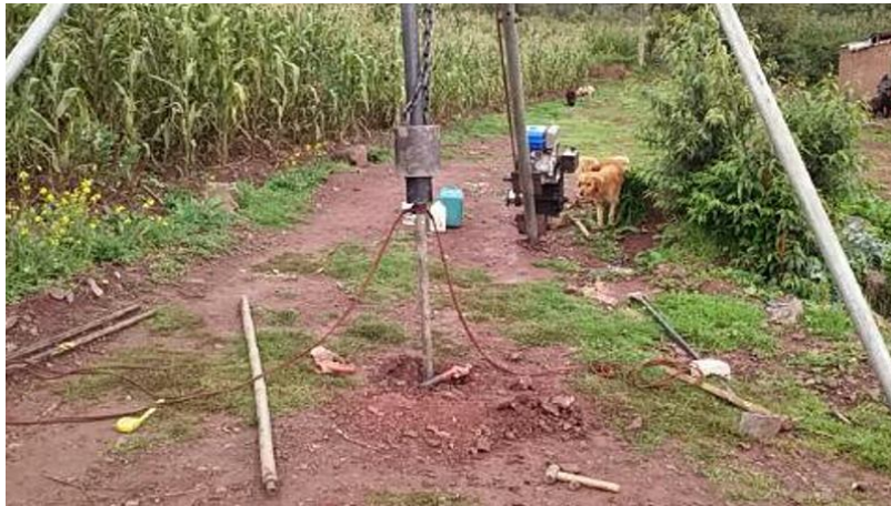
Figura 22. Instalacion del equipo de SPT
