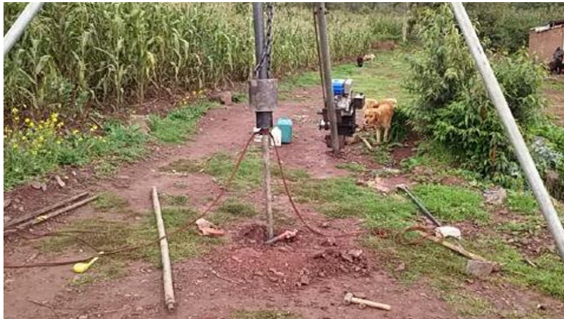
Figura 16. Instalacion del equipo de SPT
