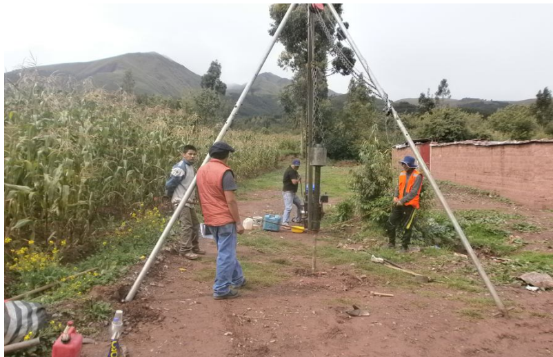
Figura 35. Realizacion de la prueba de SPT
