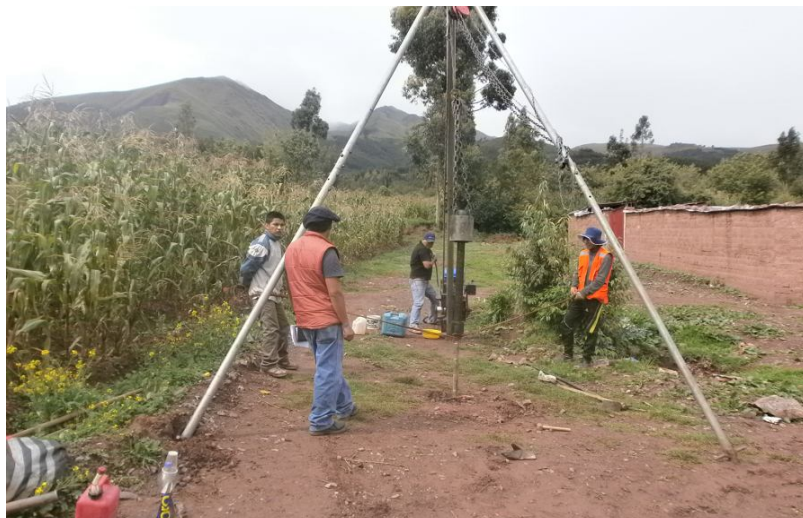
Figura 11. Realizacion de la prueba de SPT
