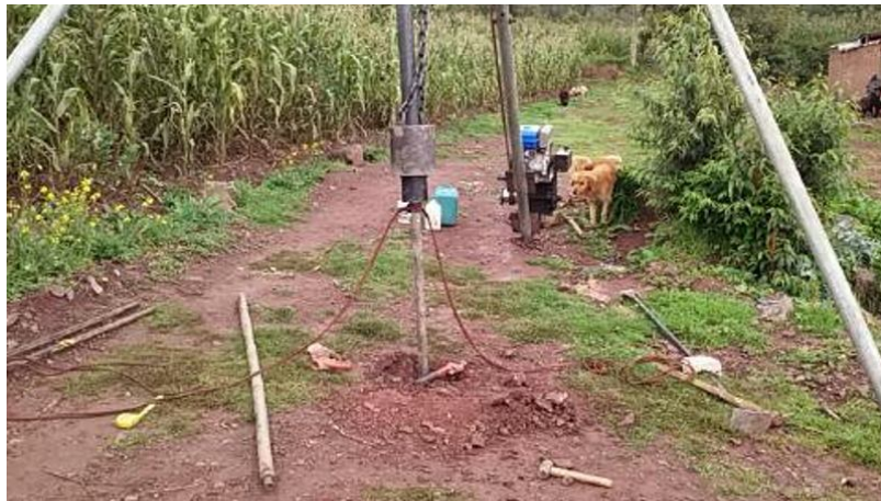
Figura 10. Instalacion del equipo de SPT
