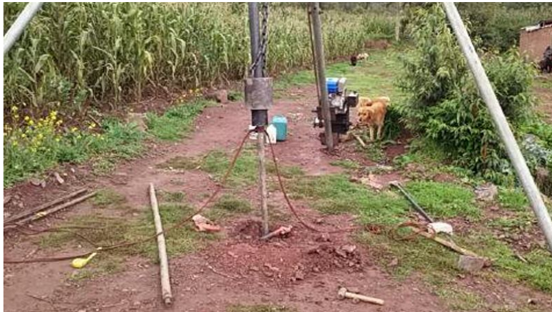
Figura 28. Instalacion del equipo de SPT
