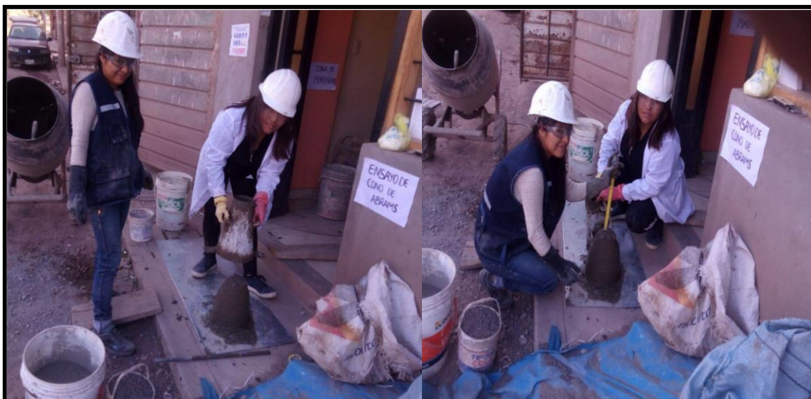
FIGURA N° 56: Proceso de Desmolde.
