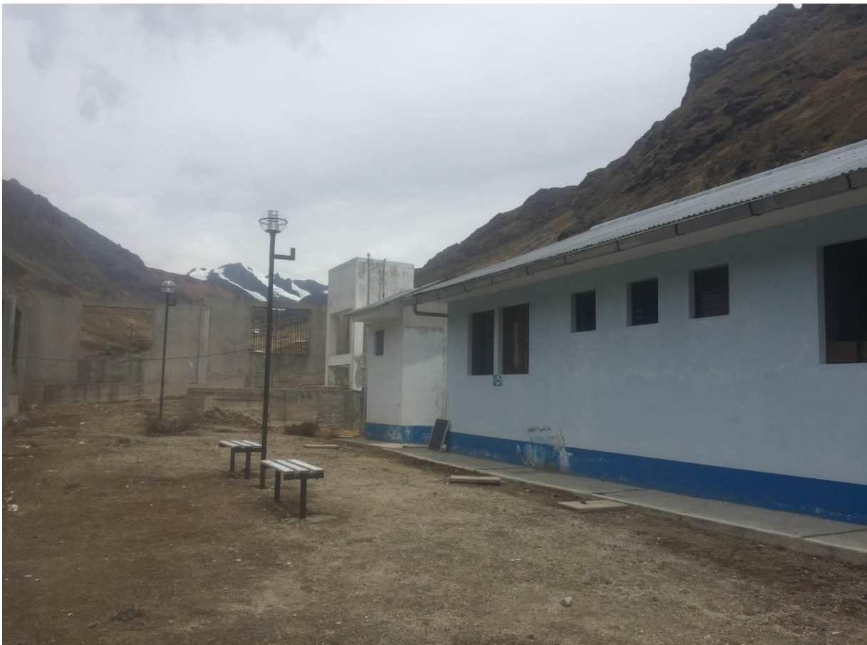
Local del Puesto de Salud Quico – perímetro Interior
