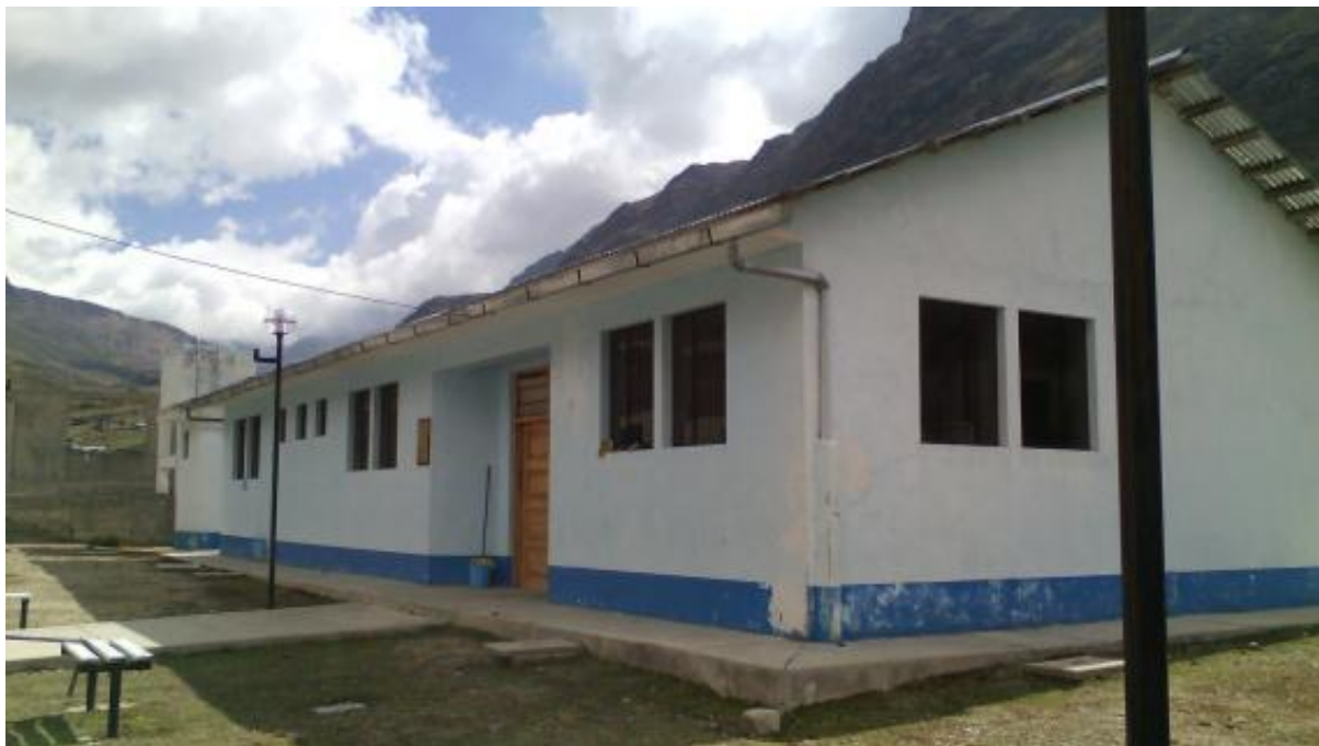
Local del Puesto de Salud Quico – perímetro Interior
