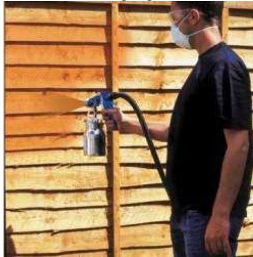
Figura N° 29: Tratamiento por pulverización en madera
