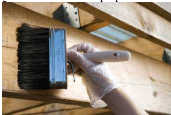
Figura N° 28: Tratamiento por pincelado en madera
