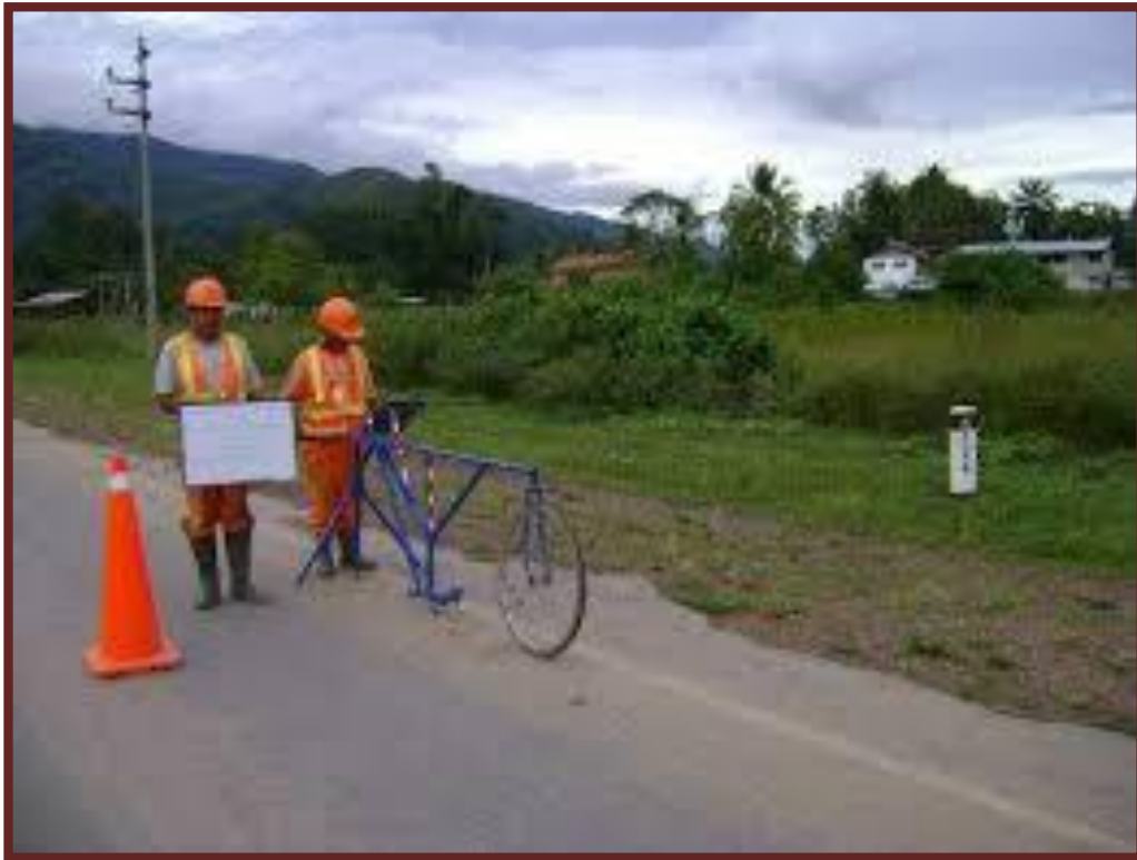
Figura N°75 Medición con el Rugosímetro de Merlín. (Pablo del águila, 2011).
