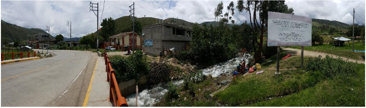
Vista panoramica de las viviendas de Pisonaypata aledañas al rio
