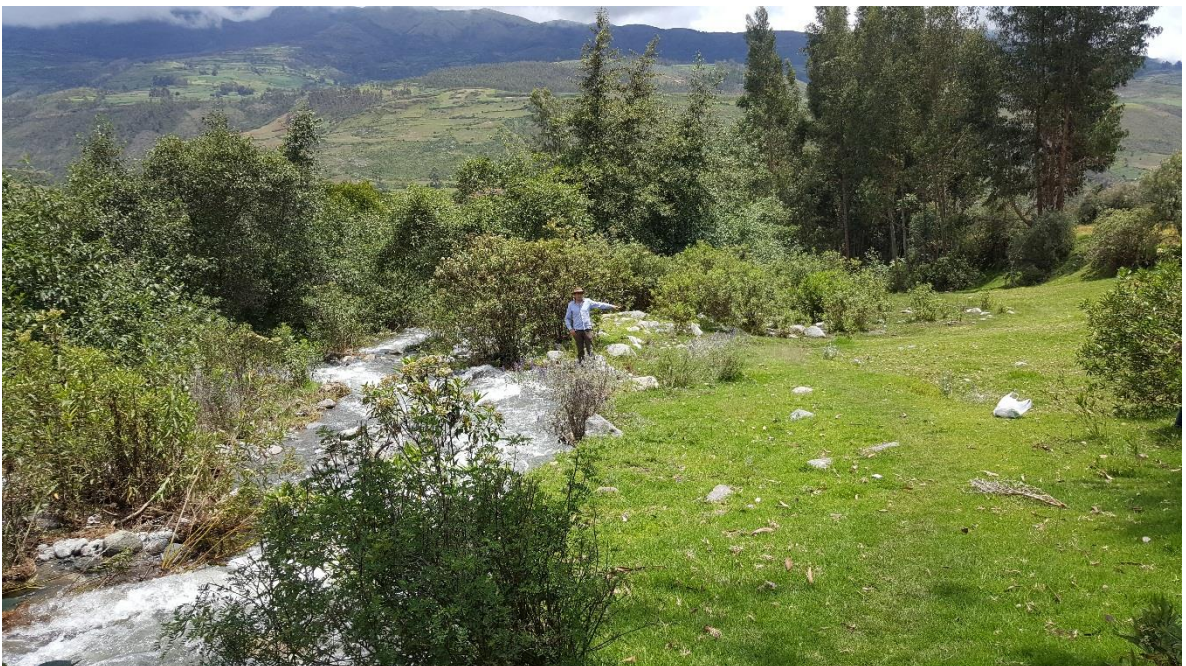
Zona de inundación identificada (0+800)
