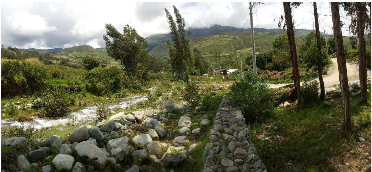
Zona de inundacion identificada (0+200)
