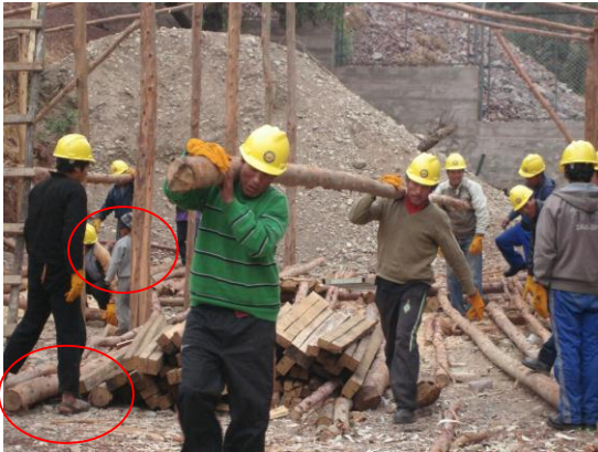
Figura N° 2 Alumnos trabajando sin identificar peligros Tambobamba Comunidades
