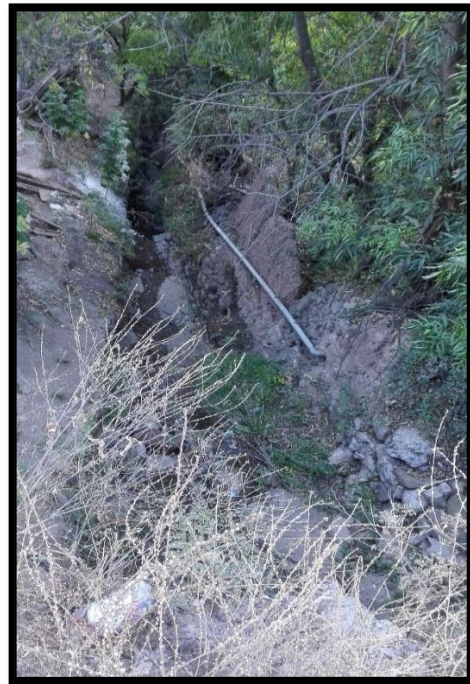
FIGURA N° 79: Canal Abierto Superficial Osqollo – Atraviesa Propiedad Privada
