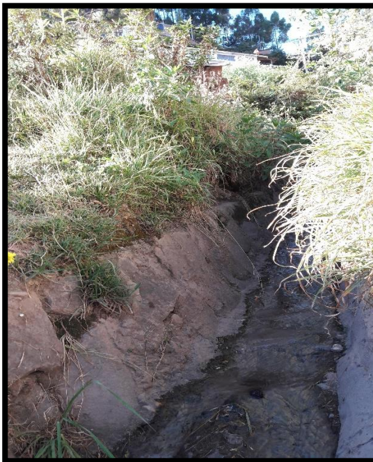
FIGURA N° 76: Canal Osqollo – se visualiza su estado de conservación
