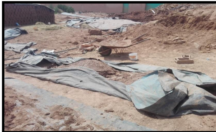
Figura N° 94: Se Coloca el Barro a Dormir Durante 1 Día. Fuente propia.
