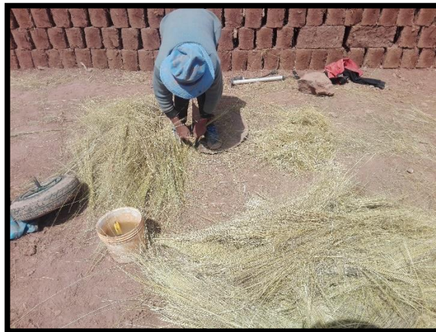
Figura N° 92: Cortado de la Paja en Tamaños de 10 cm Fuente propia.
