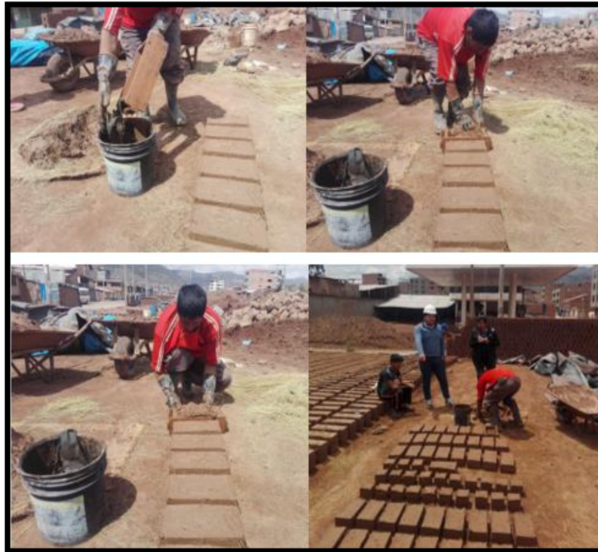
Figura N° 95: Elaboración del Adobe Fuente propia.
