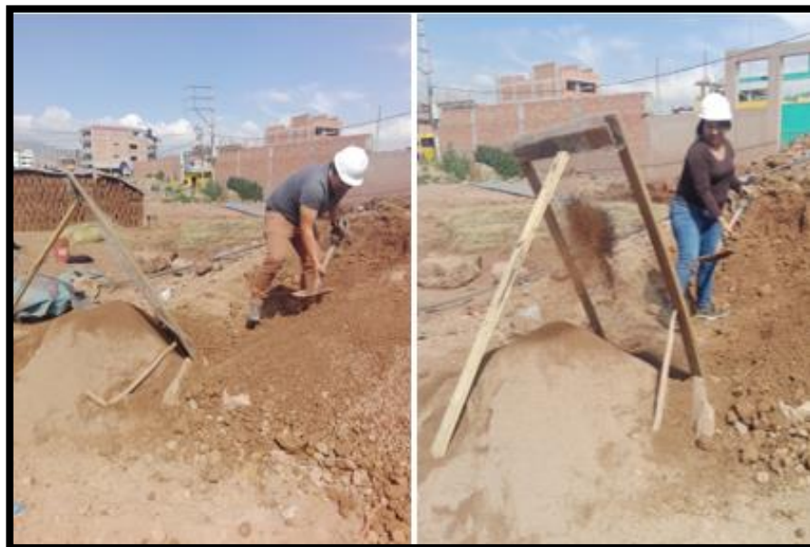
Figura N° 90: Tamizado y Seleccionado de la Tierra Para los Diferentes % de Mucílago Fuente propia.
