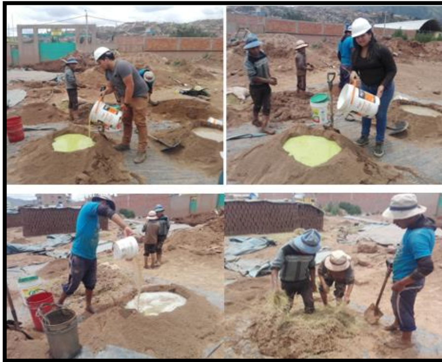
Figura N° 93: Añadimos los Porcentajes de Cada Muestra ya sea de Mucílago y de Agua. Fuente propia.
