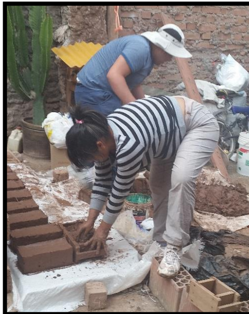
Figura N° 69: Elaboración Previa de los Adobes Fuente propia.
