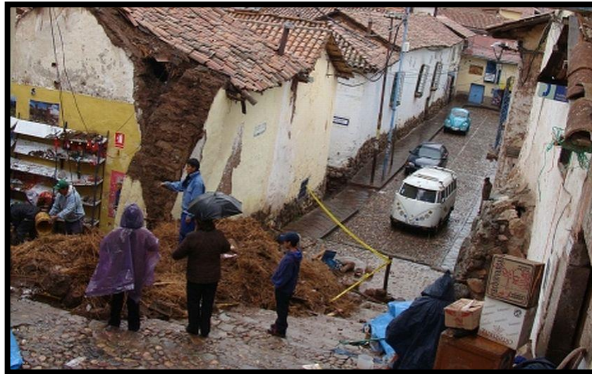
Figura N° 1: Casa de Adobe Colapsada por Fuertes Lluvias en Cusco. Fuente propia.
