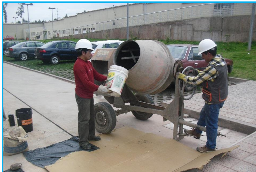
Figura 56: Dosificación y preparado de la mezcla de concreto.
