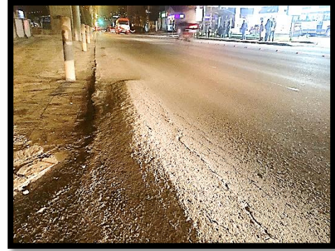
Figura 1.3: Ahuellamiento.
