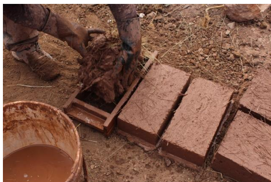
FIGURA 22 : COLOCADO DE LA MEZCLA DE BARRO EN EL MOLDE DE MADERA
