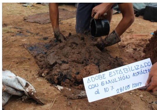
FIGURA 118 : MEZCLA DEL BARRO CON LA EMULSIÓN ASFÁLTICA
