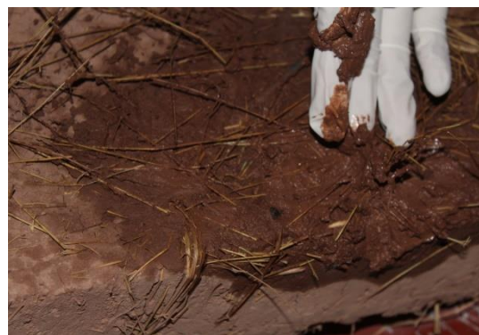
FIGURA 172 : NIVEL DE OQUEDAD DE CONSIDERACIÓN EN LAS UNIDADES DE ADOBE TRADICIONAL
