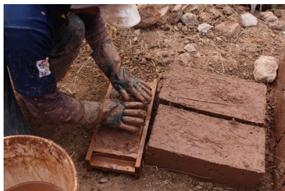
FIGURA 23 : COMPACTACIÓN DE LA UNIDAD Y ADICIÓN DE PAJA
