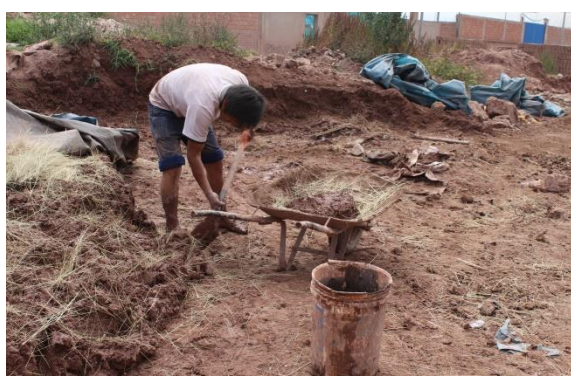
FIGURA 111: TRASLADO DEL MATERIAL PARA SER MOLDEADO
