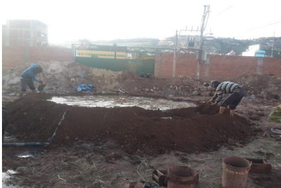
FIGURA 109: PREPARACIÓN DEL BARRO PARA LA ELABORACIÓN DE ADOBES
