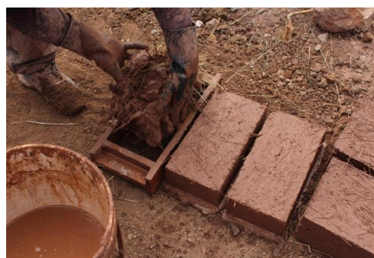
FIGURA 114 : COLOCADO AL MOLDE DE MADERA
