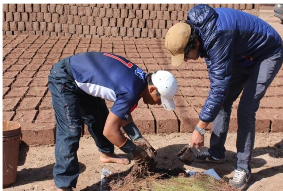
FIGURA 117 : MEZCLA DEL BARRO CON LA EMULSIÓN ASFÁLTICA
