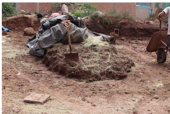
FIGURA 20 : DORMIDO DE LA MEZCLA DE BARRO POR UN MÍNIMO DE 01 DÍA
