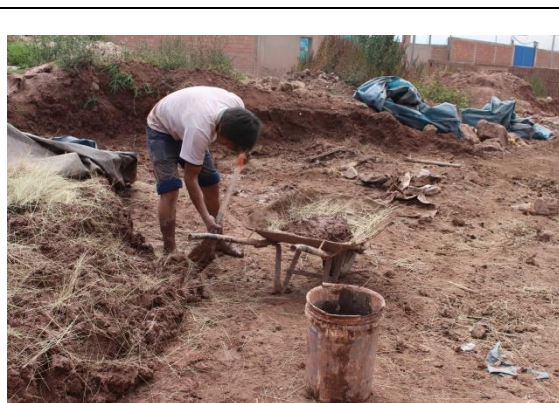
FIGURA 19 : PISADO DE LA MEZCLA DE BARRO
