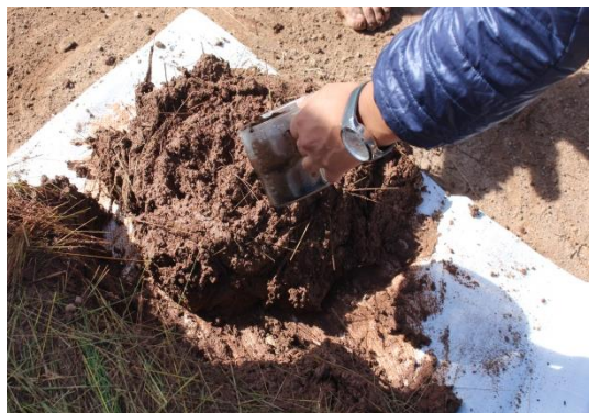
FIGURA 116 : COLOCACIÓN DE EMULSIÓN ASFÁLTICA A LA MEZCLA DE BARRO
